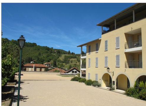
ZAC du nouveau centre - ©Agence d'urbanisme
