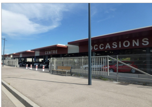
Le pôle automobile derrière la gare. ©Agence d'urbanisme
