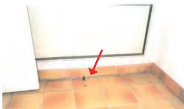
Affaissement du plancher mis en évidence par le décalage entre plinthes et dallage - Maison Jourdan.
