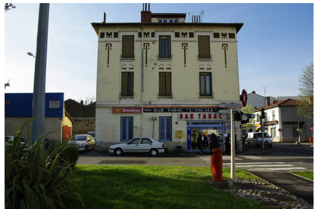
Immeuble faubourien avenue J. Jaurès © Agence d'urbanisme Lyon
