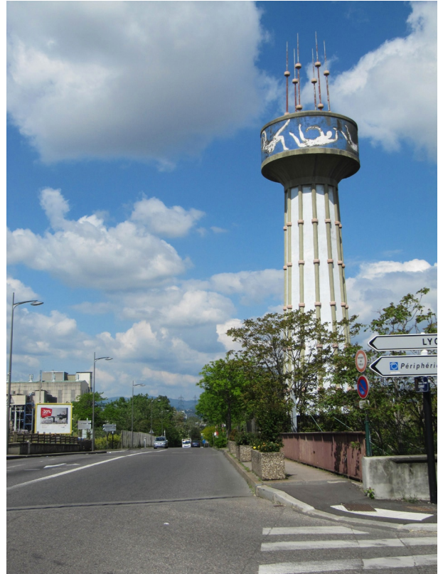
Château d'eau © Agence d'urbanisme Lyon
