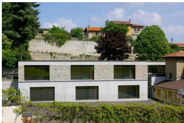
Extension de l'école de Saint-Fortunat © Clément Vergely Architectes, Erick Saillet
