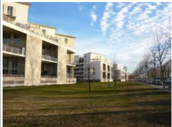
Res-de-chaussée surélevé. Résidence 'L'autre Quai', quartier Coeur de Bastide, Bordeaux - Atelier Yves Lion
