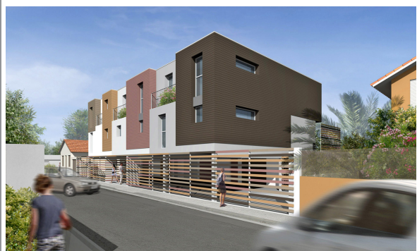
Maisons groupées, bardage aéré en rez-de-chaussée - source : lhenry-architecture.com
