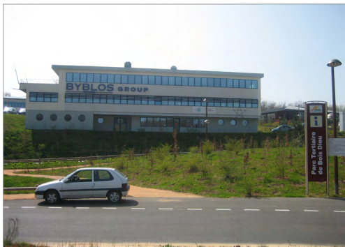
Parc tertiaire de Bois Dieu - ©Agence d'urbanisme, Henry E
