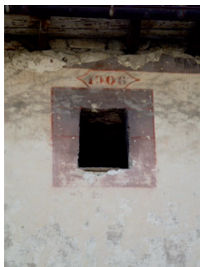
un enduit «rustique» sur une des loges : une finition balayée
