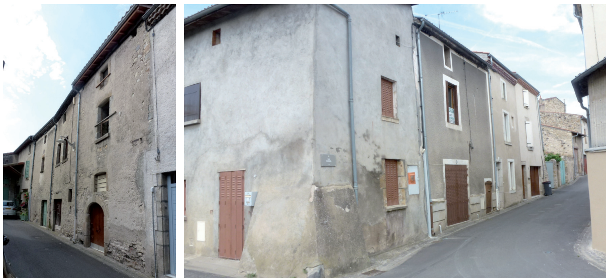
alternances d'aspects : dégradé des enduits
