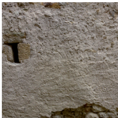
un enduit «rustique» sur une des loges : une finition balayée
