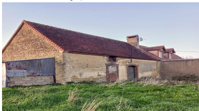
Photographie du bâtiment
