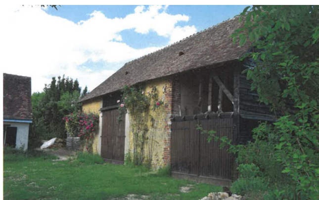
Photographies du bâti objet du changement de destination SAC37
