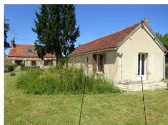
Côté B Entrée clientèle
