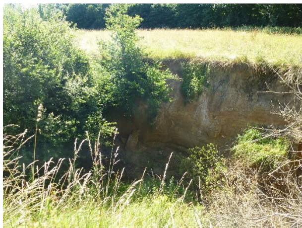
Photo 17 : Ripisylve avec effondrement de la berge
