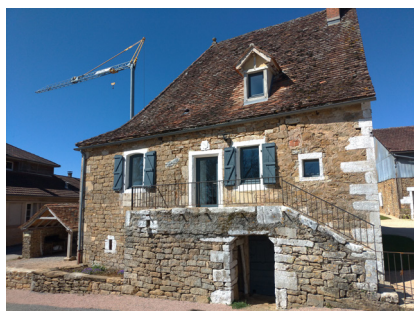
Réhabilitation d'une maison ancienne dans le village d'Albiac
