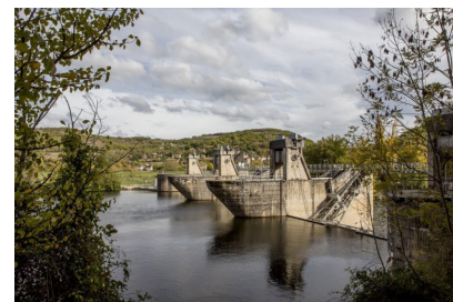
Centrale hydroélectrique de Cajarc (crédit : Médialot)
