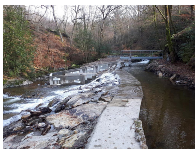
Seuil du captage de la station de Longuecoste (Montet-et-Bouzal)
