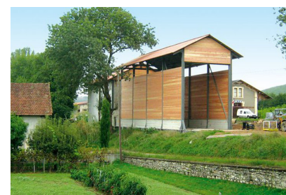
Chaufferie bois de Cajarc
