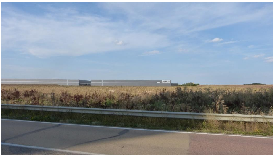
La zone vue depuis la RD 369
