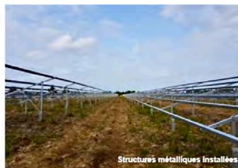
Structures installées (source : BayWa r.e.)
