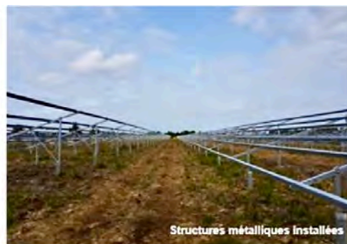
Structures installées (source : BayWa r.e.)
