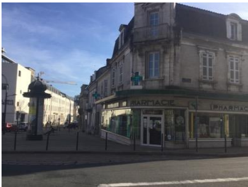
Enseigne lumineuse en façade, Périgueux, mars 2021
