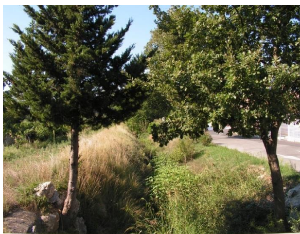
Fossé pluvial après le passage sous la RD980 à St Nabor
