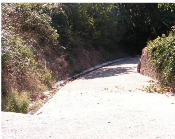
Rigole le long d'un sentier (entre le village de Cornillon et le quartier résidentiel du Pesquier)
