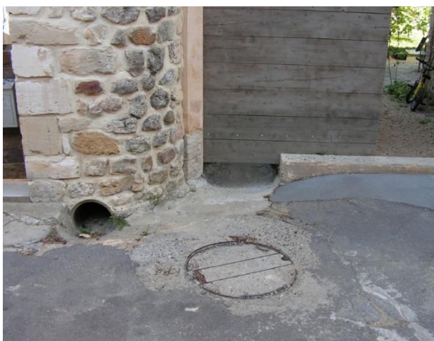
Rigoles d'évacuation des eaux pluviales dans le vieux village de Cornillon
