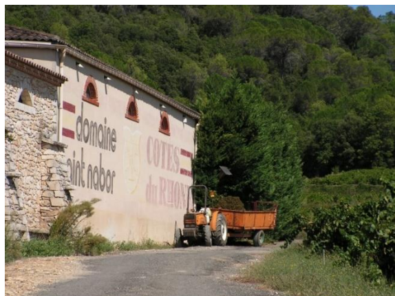
Bâtisse du Domaine St Nabor sur la RD980
