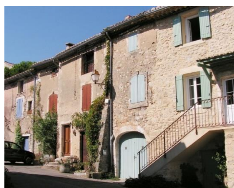
Façades des maisons autour de la place
