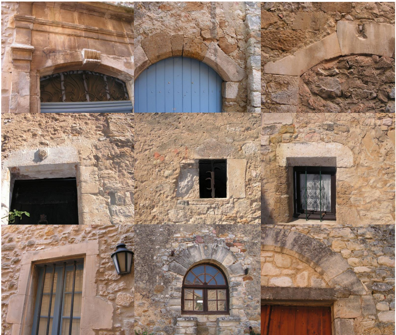
Détails des encadrements d'ouvertures en pierre de taille (portes, fenêtre et fenestrons)
