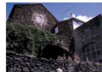
Extension d'un bâti ancien
