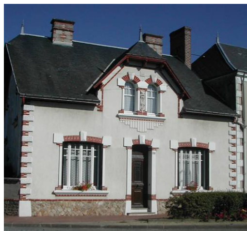
Utilisation de la Brique industrielle en ornement sur une construction début XX e place du Monument, Luché.
