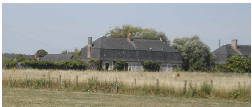
La Ménagerie semble dater de la fin du XVII e siècle ; elle est couverte d'une toiture à bris mansard. Elle a peut-être abrité un haras.
