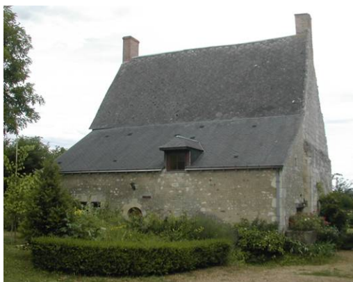
La Leu, toiture à deux pentes et pignon droit La pente très forte est caractéristique de l'époque médiévale. (l'appentis est plus tardif)
