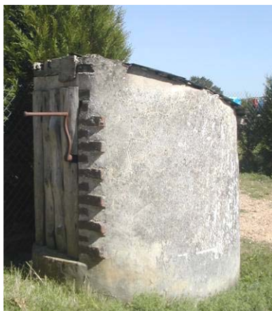
Puits du village des Lévradières
