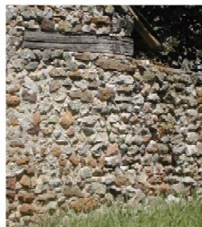
mur de bloc de silex
