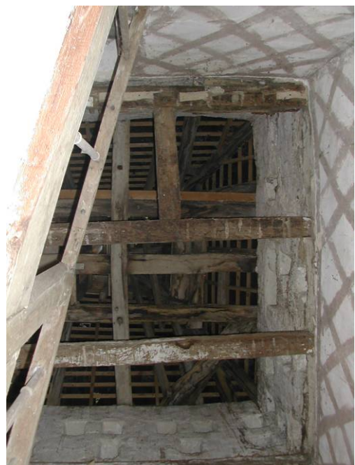
Charpente de la tour pigeonier de la «maison des sœurs»
