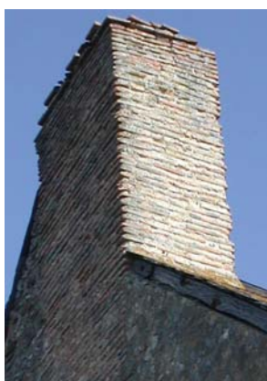
Cheminée en carreaux traditionnels de brique
