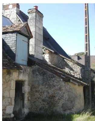
les Lévradières, four avec sa cheminée en bord de toiture.
