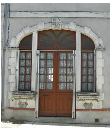
Détail : utilisation de pilastres cannelés et ligne de briques en soubassement
