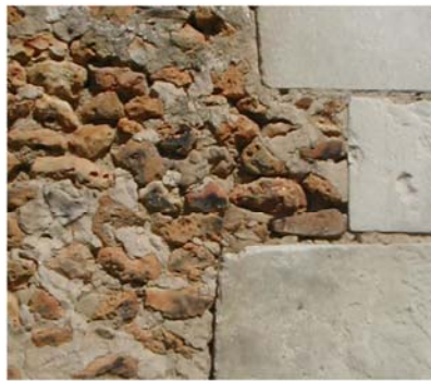
joints de mortier affleurants
