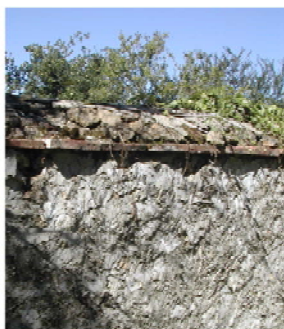
couronnement avec une ligne de carreaux de briques
