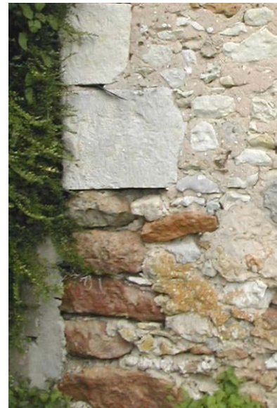
Chaînage d'angle avec grès en partie basse, et tuffeau en partie supérieure. Maçonnerie mixte.
