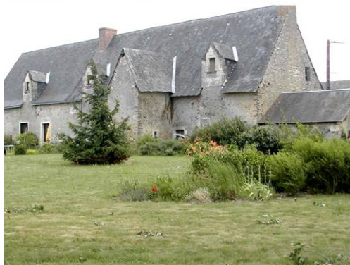
La ferme de Maupas semble d'origine ancienne : la partie Ouest comporte l'emplacement d'une belle fenêtre à meneau de type XV-XVI e .
