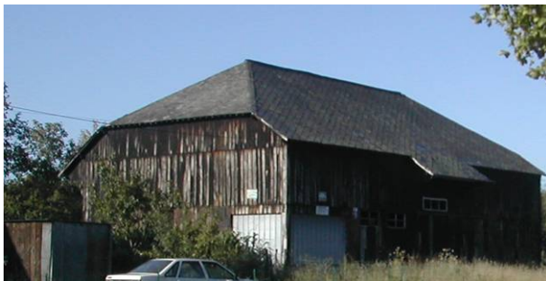
Hangar agricole près de l'ancienne gare. Aujourd'hui le bois reste utilisé sous forme de bardage pour les bâtiments d'exploitation agricole.
