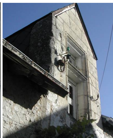
Lucarne située à l'Est de la place du Monument (bourg de Luché)
