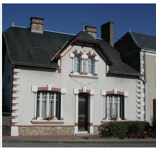
Construction datée de 1935
