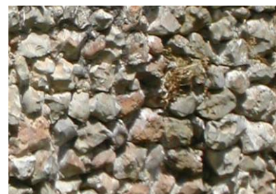
Maçonnerie de moellons en silex.
