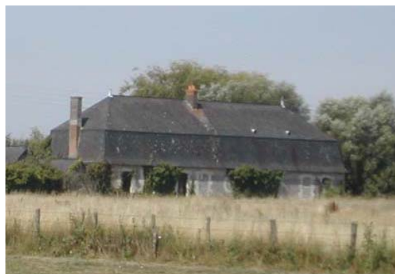
La Ménagerie, toiture à quatre pentes comportant un bris mansard. La souche de cheminée se dégage du pignon.
