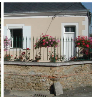
muret avec grille
