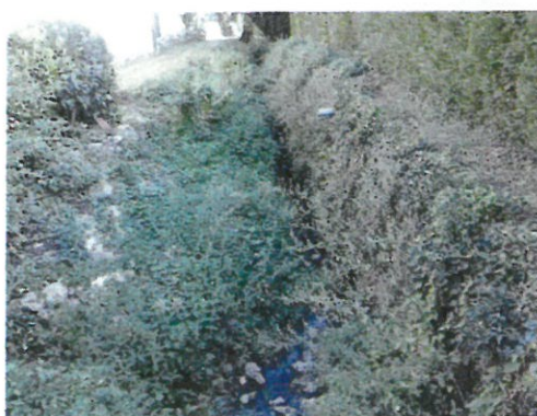
Exutoire rue de Maldret
