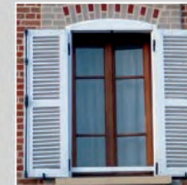
Volet persienné en bois. Ici la fermeture est à crémone (barre verticale).
