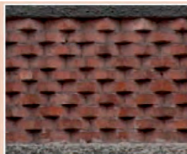
En relief. Ici, les pointes des briques sont décalées.
