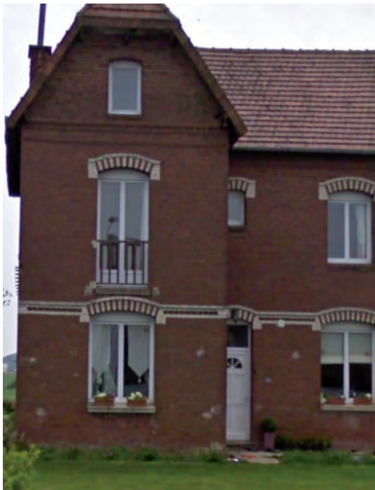
Bâti de la reconstruction R+1+C
