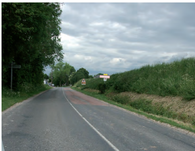
Entrée Nord-est par la D42
