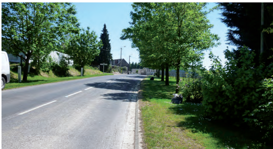
Entrée Ouest par la D938
