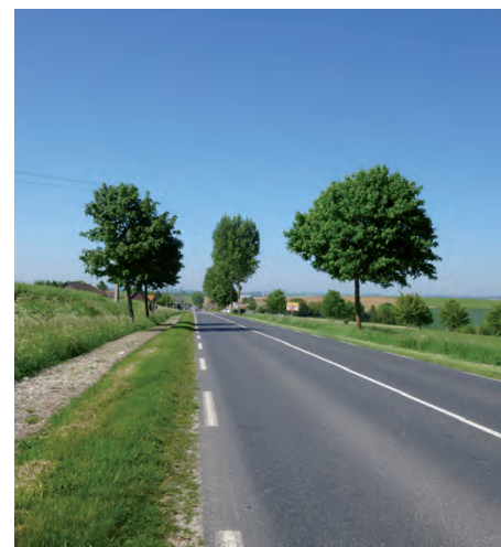
Entrée Nord-Est par la D929
