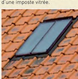
Lucarne «tabatière». Simple châssis de toit.
