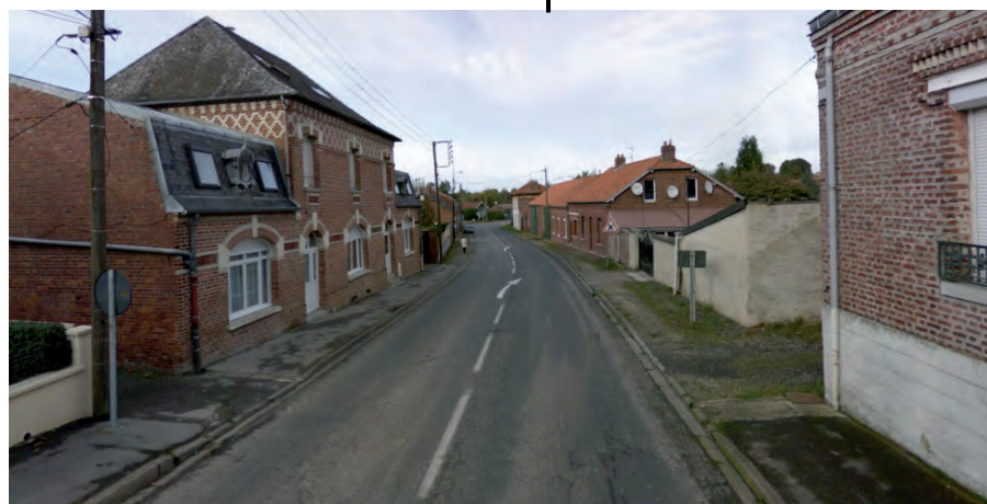
Habitations R+1+C et R+C anciennes groupées, à l'alignement de l'espace public
