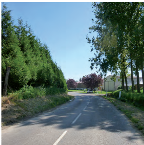
97 Entrée Nord Ouest par la D176
