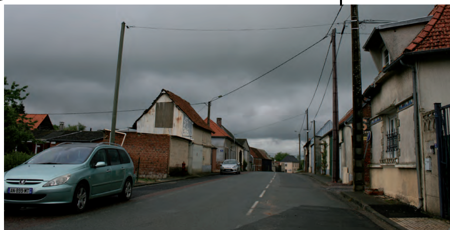
Habitat ancien groupé dominant R+C aligné sur l'espace public.
