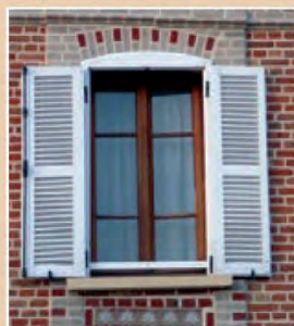
Fenêtre en bois, à deux vantaux. Ici, elle a des volets persiennés.
