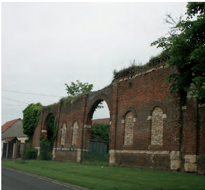
Méricourt-Sur-Somme - parcelles 11 et 12 : architecture remarquable avec arches. Utilisation de pierre (rare).
