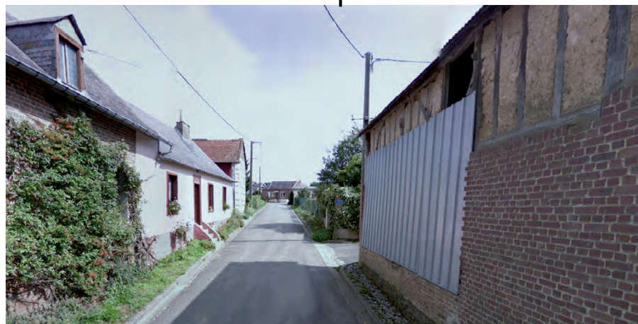
Typologies anciennes groupées R+C à l'alignement de l'espace public
