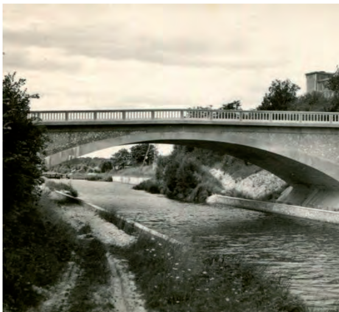
Hameau de Froissy - La-Neuve-lès-Bray - RD329 : pont de la reconstruction 1945
