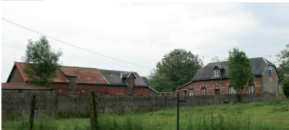
Ferme à Grandcourt caractéristique par la création de lucarnes, un bâtiment d'exploitation détaché de l'habitation et des modénatures de briques.
