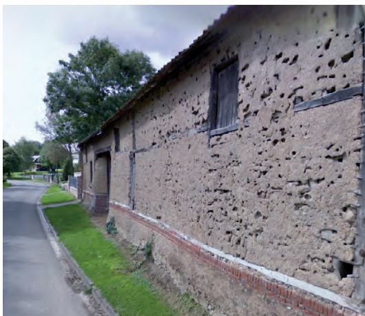
Ferme en torchis R+C avec soubassement 42en brique
