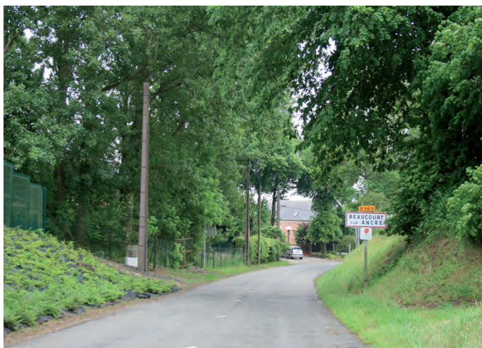
Entrée Nord-ouest par la D163
