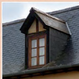
Lucarne à «bâtière». Sa toiture a 2 pans.
