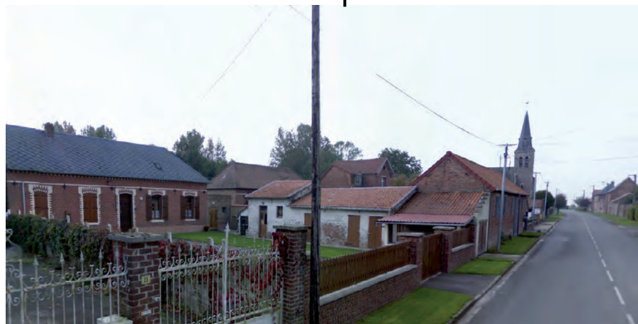
Implantation dominante à l'alignement de l'espace public avec quelques exceptions. Bâti ancien groupé R+C dominant.
