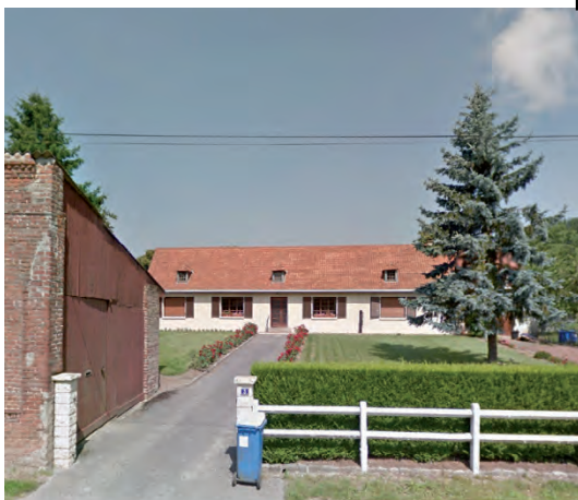
Typologie d'une ancienne ferme à plan carré dont la grange a été démolie
