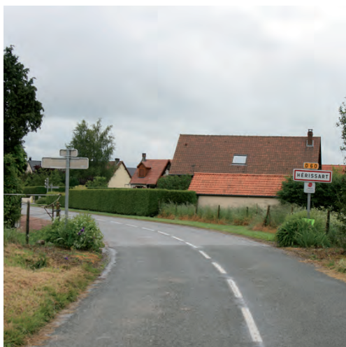
Entrée Ouest par la D60
