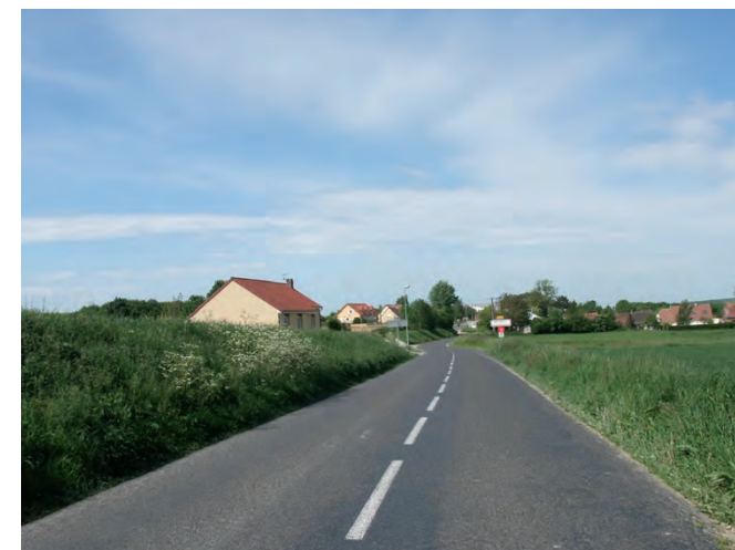
Entrée Nord-Est par la D64
