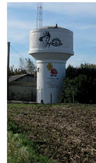
Château d'eau avec fresque dédiée aux Australiens à Pozières
