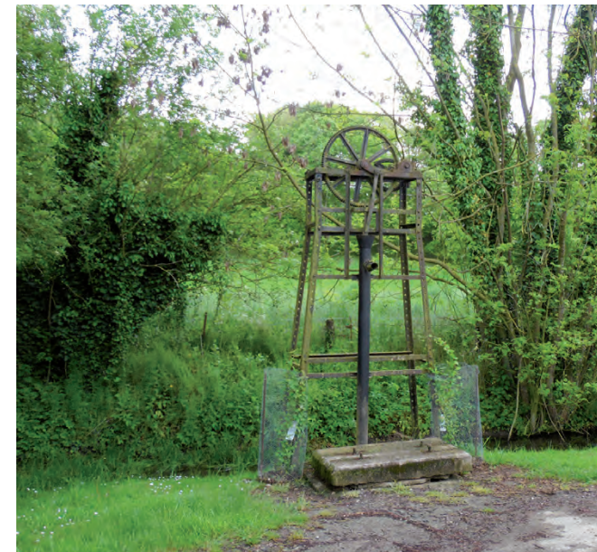
Marieux - parcelle 99 : puits avec pompe patrimoniale
