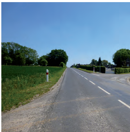
Entrée Ouest par la D938
