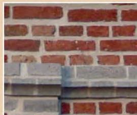
Brique du nord. Sa dimension est de 22 x 11 x 6 cm, sa forme et sa couleur varient selon les argiles qui la compose et la durée de cuisson artisanale.
