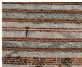
Appareillage «rouge barre». Mise en œuvre qui superpose un ou plusieurs lits de brique et un lit de moellons de craie.
