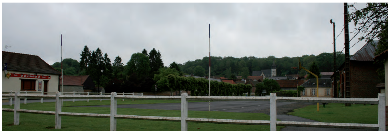
Coupe CD : Depuis la D23, l'église de Toutencourt est en point haut du village, adossée au bois sur coteau.
