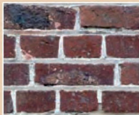
Appareillage « à la française ». Mise en œuvre de la brique qui superpose un lit de largeur et un lit de longueur de brique.
