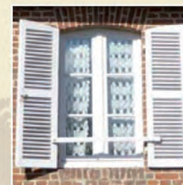
Volets persiennés en bois. Fermeture à fléau (barre transversale).
