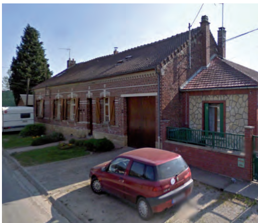
Habitat de la reconstruction R+C
