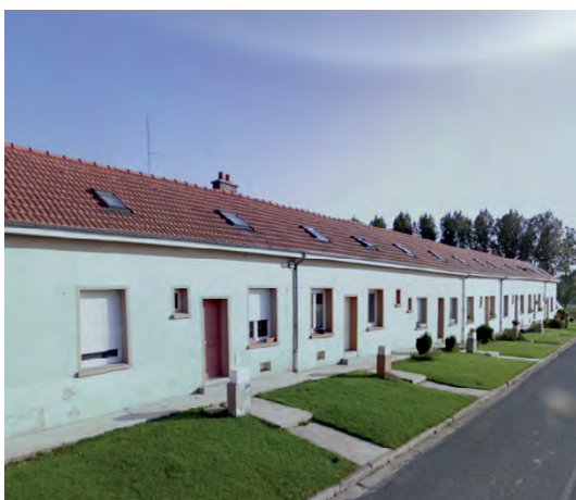
Habitat Groupé R+C en crête de relief
