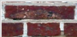
Brique du Nord. Sa dimension est 22 x 11 x 6 cm, sa forme et sa couleur varient selon les argiles qui la compose et la durée de cuisson artisanale.
