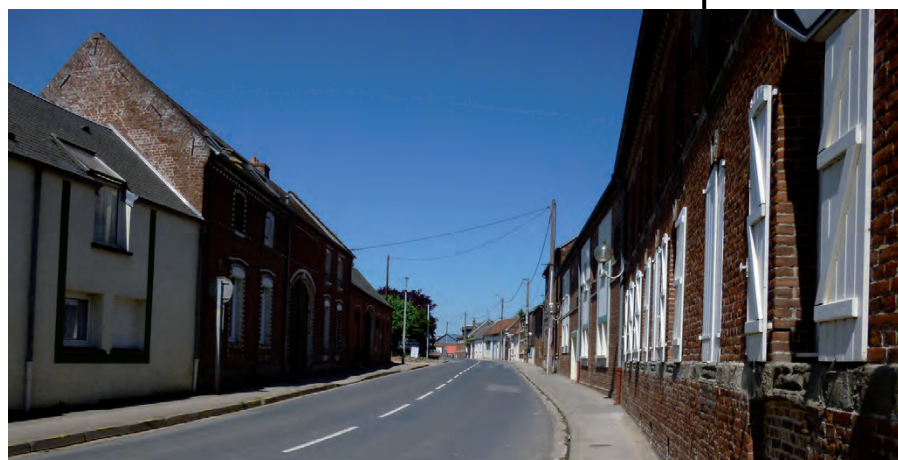
Habitat groupé R+1+C en briques à l'alignement de la rue principale
