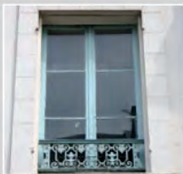
Fenêtre à deux ouvertures ou «vantaux» et à petits bois
