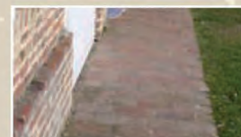
Trottoir en brique, en pied de façade.
