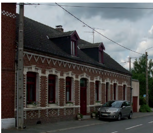
Typologie R+C de la reconstruction typique avec modénatures de briques
