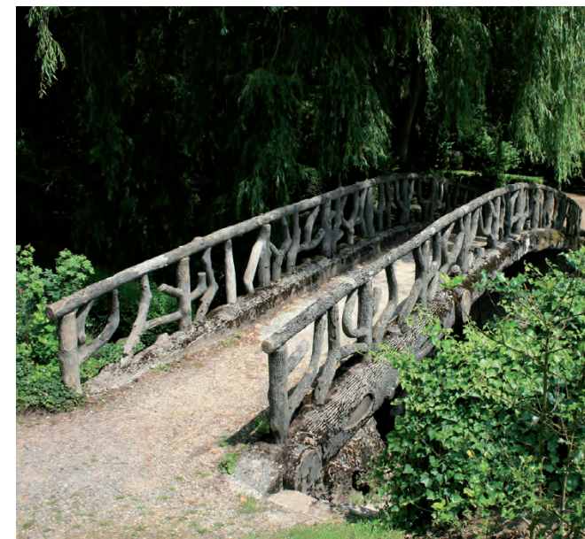
Albert - parcelle 35 : pont avec béton décoratif imitation bois
