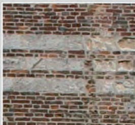
Appareillage «rouge barre». Mise en œuvre qui superpose un ou plusieurs lits de brique et un lit de moellons de craie.
