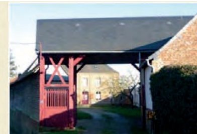
Porte «charretière». Sa taille permet le passage de la charrette à foin. Elle est composée de 2 grandes portes en bois plein, redivisées en partie haute à claire voie et munies d'un passage piéton en partie basse.
