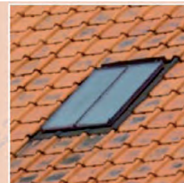
Lucarne «tabatière». Simple châssis de toit.
