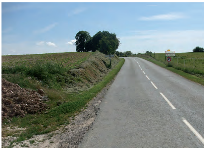
Entrée Ouest par la D91
