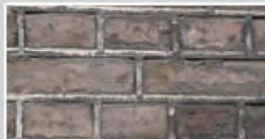
Ici, les joints sont en relief, dénommés joints «à l'anglaise».
