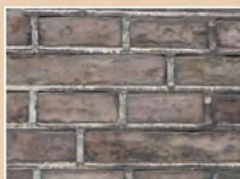
Brique. Devenue grise avec le temps, ici le joint est réalisé en relief, dénommé « joint à l'anglaise ».
