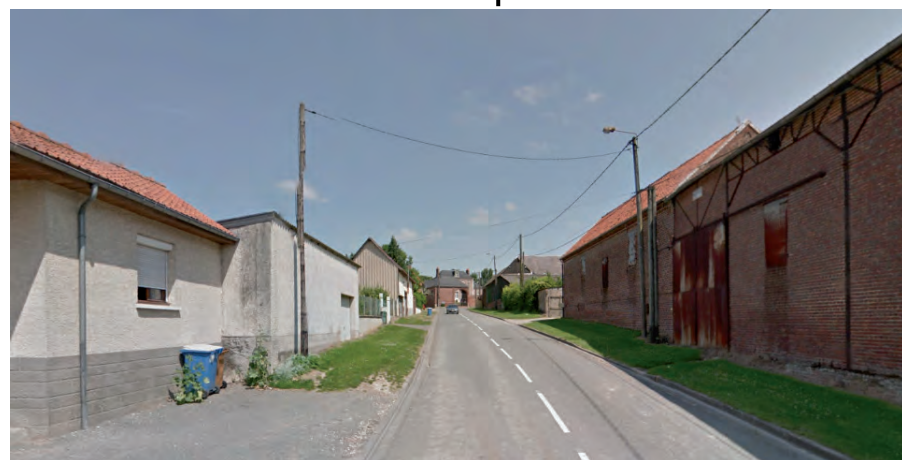
Habitat ancien groupé R+C à l'alignement de l'espace public
