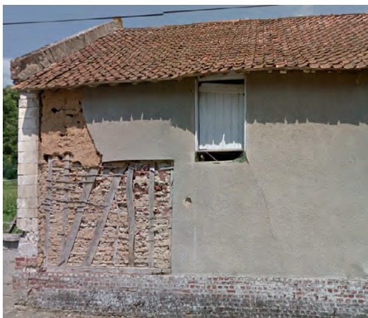
Typologie R+C où l'ancien torchis est visible sous le crépi. Soubassement brique.
