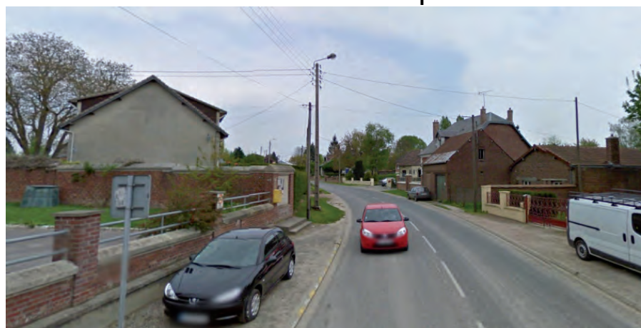
Habitat ancien et récent R+C le plus souvent non groupé et non aligné sur l'espace public.
