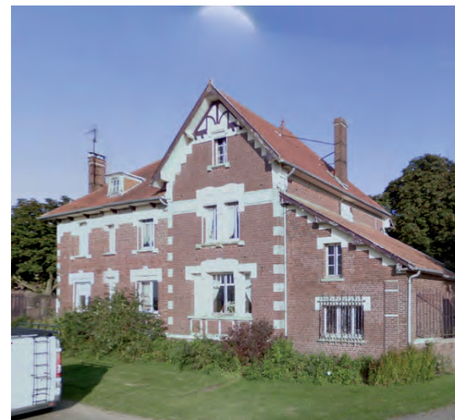
Thiepval - parcelle 104 : ferme avec maison de maître de la reconstruction, pignon de style néo-Normand
