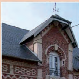
Lucarne «passante». Elle se situe en prolongement du mur de façade.
