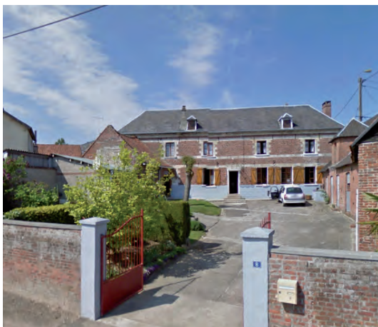
Bâti ancien R+1+C avec cour ouverte sur l'espace public
