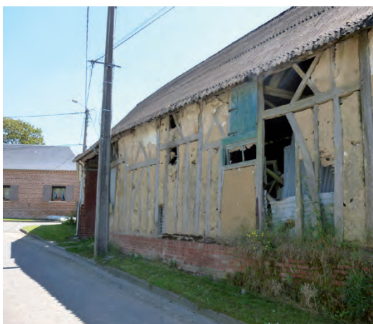
Typologie R+C en torchis avec ossature bois et soubassement brique
