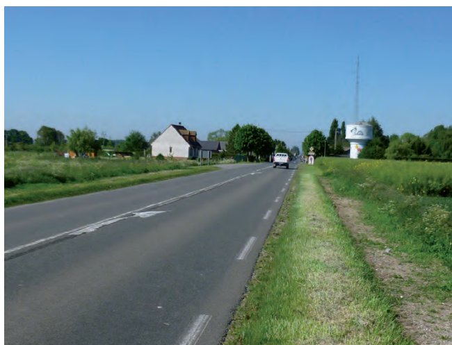
Entrée Nord-Est par la D929
