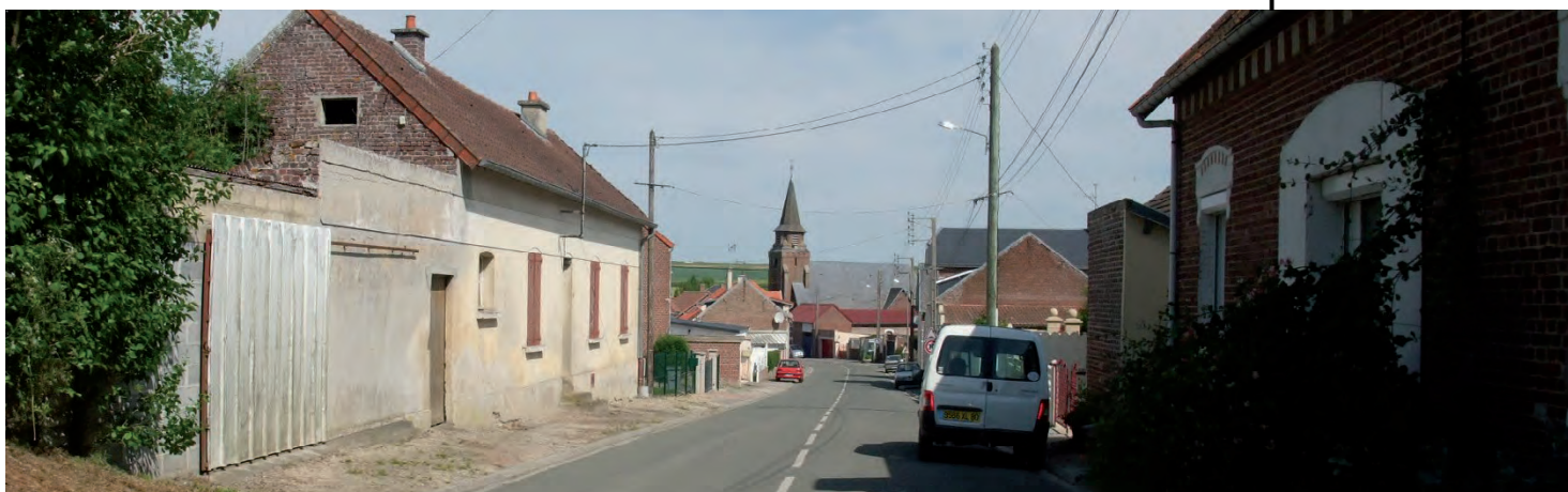
Habitat R+C groupé dominant. Alignement à l'espace public.
