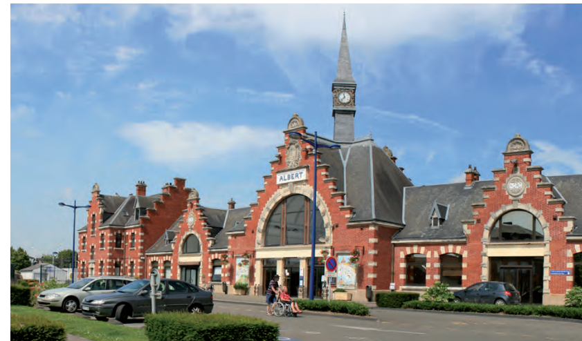
Gare d'Albert : un magnifique témoignage du style Néo-Flamand avec les pignons à pas de moineaux ou pignons à redents.
