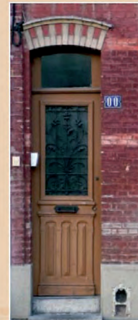
Porte d'entrée vitrée et grille de ferronnerie. Elle est surmontée d'une imposte vitrée.
