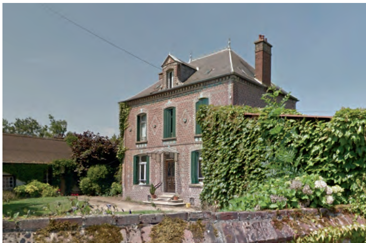
Maison bourgeoise avec épi et crête de faîtage à Arquèves
