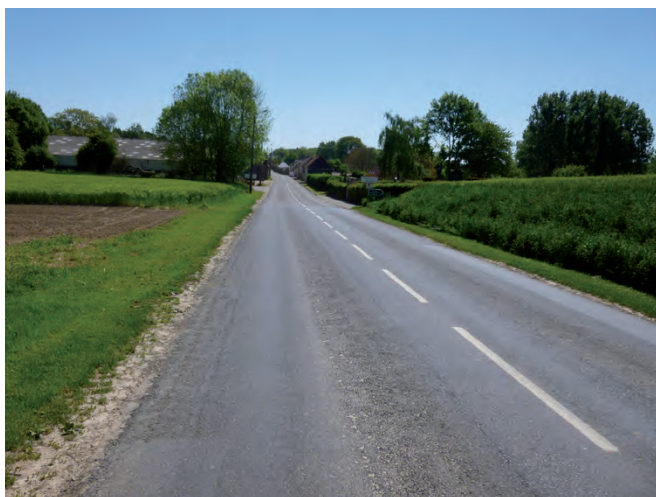
Entrée Ouest par la D938
