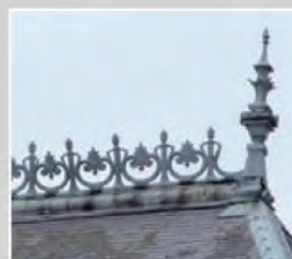
Epi et crête de faîtage en ferronnerie.
