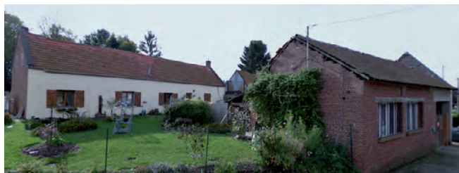
Bus-lès-Artois : type 5 en maçonnerie de briques
