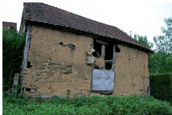
Raincheval: ossature apparaissant sous le torchis
