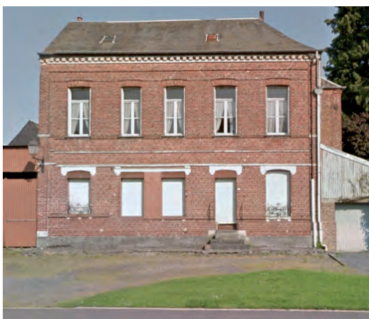
Bâti de la reconstruction R+1+C avec trottoir large sur l'espace public
