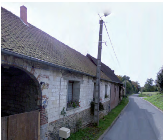
Habitat ancien groupé R+C à l'alignement de l'espace public
