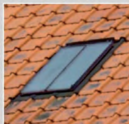
Lucarne «tabatière». Simple châssis de toit.
