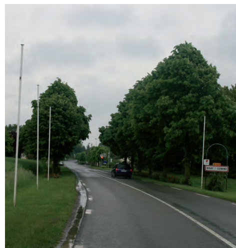
Entrée par Nord ouest par la D329
