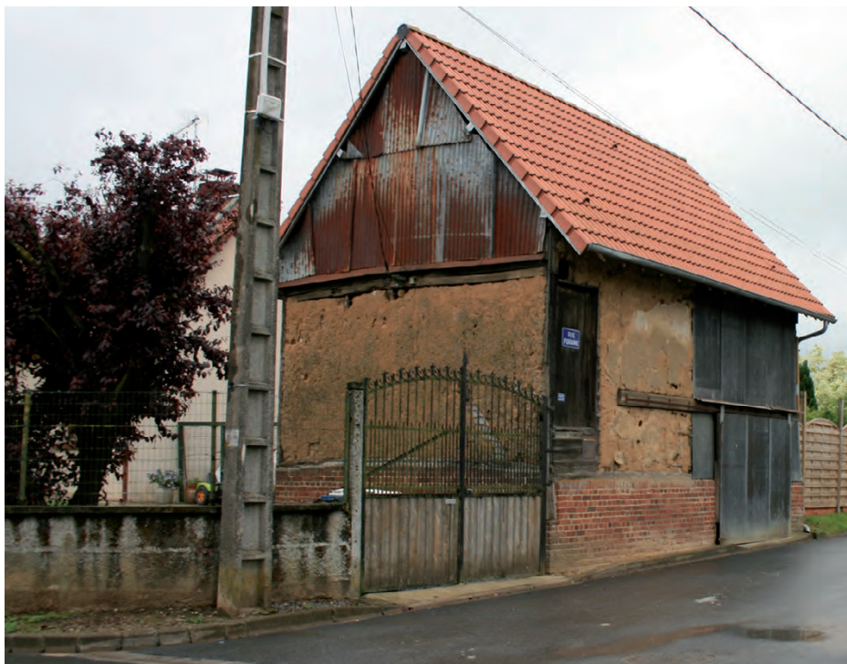
à Hérisart, maison paysanne avec soubassement brique. Bardages métalliques sur pignons peu respectueux de l'identité rurale.
