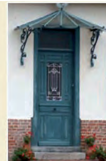
Porte d'entrée surmontée d'une imposte vitrée et ici d'une marquise en verre et ferronnerie.
