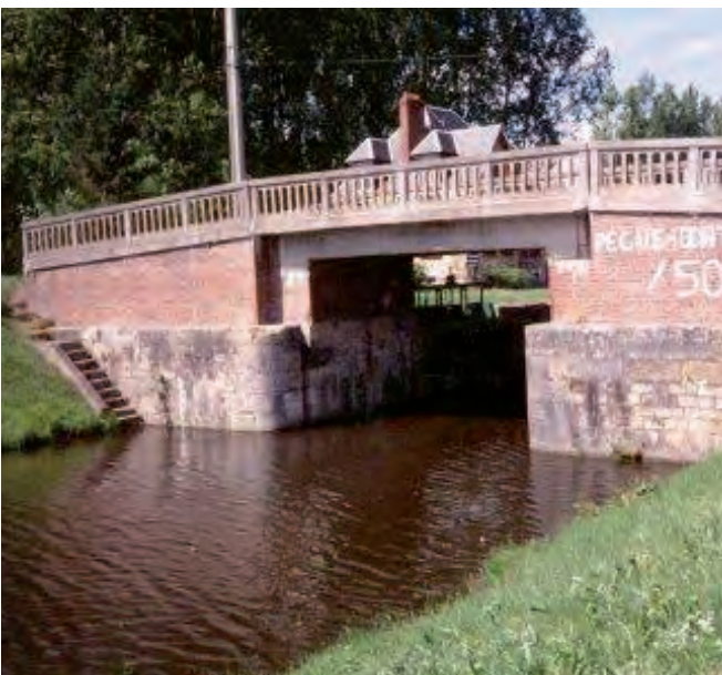
Méricourt-Sur-Somme - proche parcelle 9 : pont de la reconstruction 1945 avec soubassement grès.
