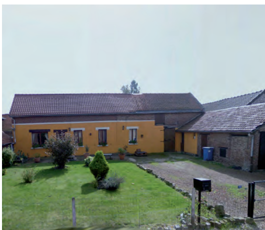
Habitat ancien R+C en cour ouverte sur l'espace public
