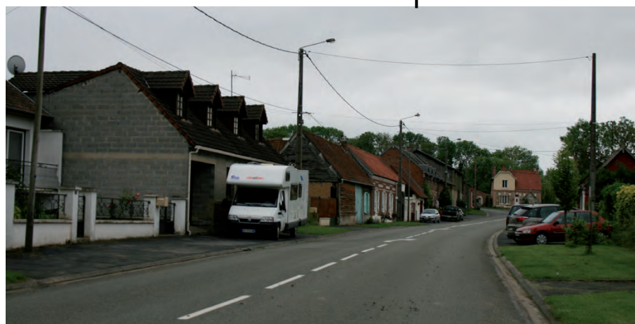
Habitat ancien R+C groupé aligné sur l'espace public dominant
