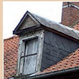
Lucarne « à batière ». Elle a une toiture à 2 pans.
