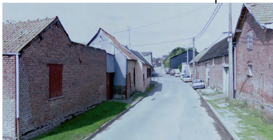
Typologies anciennes groupées R+C à l'alignement de l'espace public
