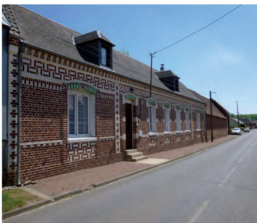
Habitat de la reconstruction R+C
