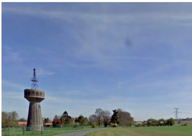
Coupe AB : Un relief de plateau onduleux depuis la D114. La ligne haute tension domine le village.
