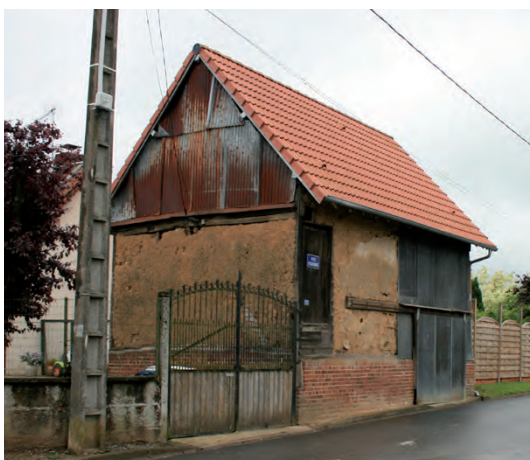
Construction en torchis avec ossature bois R+C
