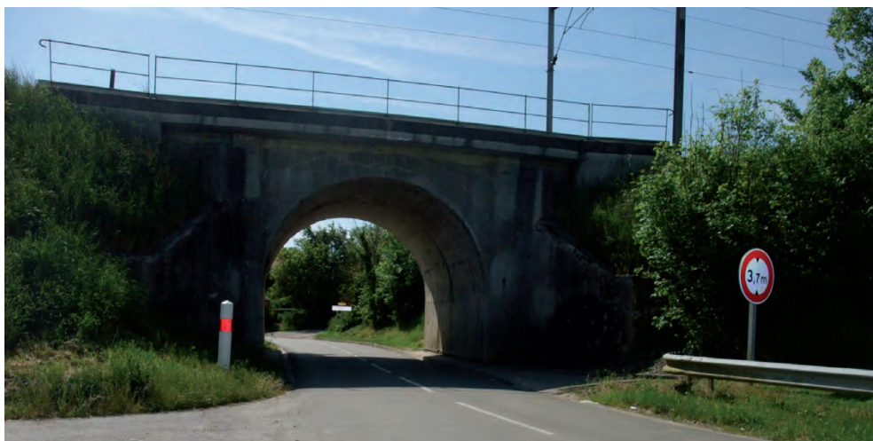
Entrée Ouest par la D52
