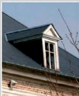
Lucarne à «bâtière». Sa toiture a 3 pans.
