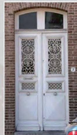
Porte d'entrée en bois. Souvent large et haute, parfois à deux vantaux, surmontée d'une imposte vitrée.
