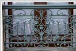
Barre d'appui et garde-corps en ferronnerie.
