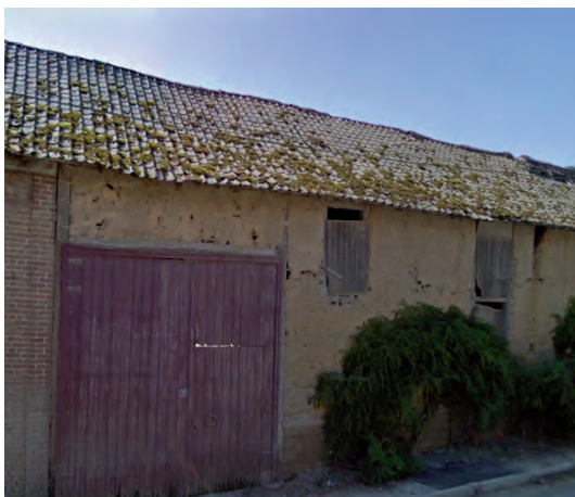
Construction en torchis avec ossature bois 28R+C
