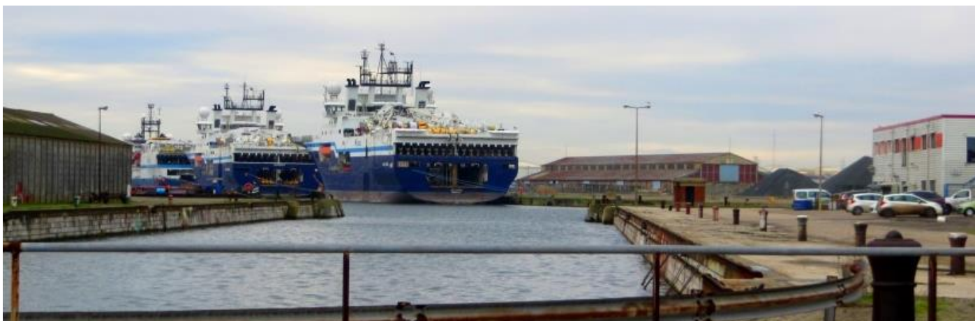
Les infrastructures portuaires et industrielles (sources : Even conseil)
