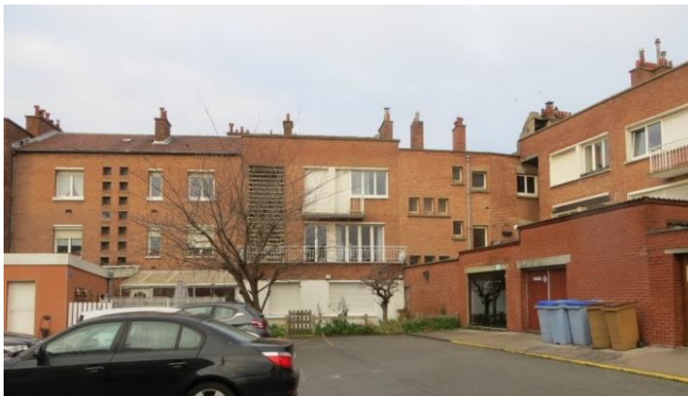
Immeubles de la reconstruction d'après-guerre, Dunkerque (Source : Even conseil)
