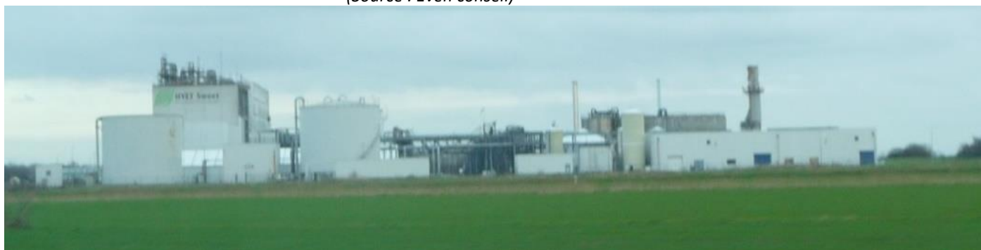
Nouvelle implantation de bâtis agricoles et industriels peu intégrés dans le paysage à: Loon-Plage (Source : Even conseil)
