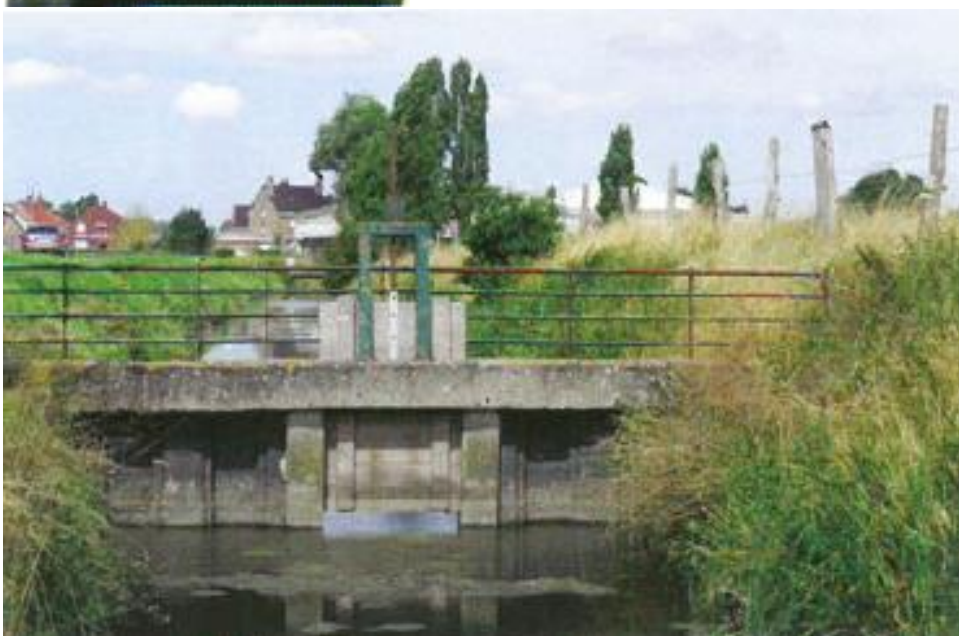
Des ouvrages hydrauliques constituant des obstacles à l'écoulement des cours d'eau (source : Even conseil)
