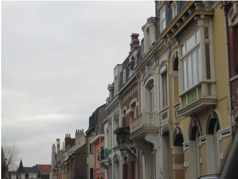
Villas en front de mer à Malo-les-Bains (Source : Even conseil)
