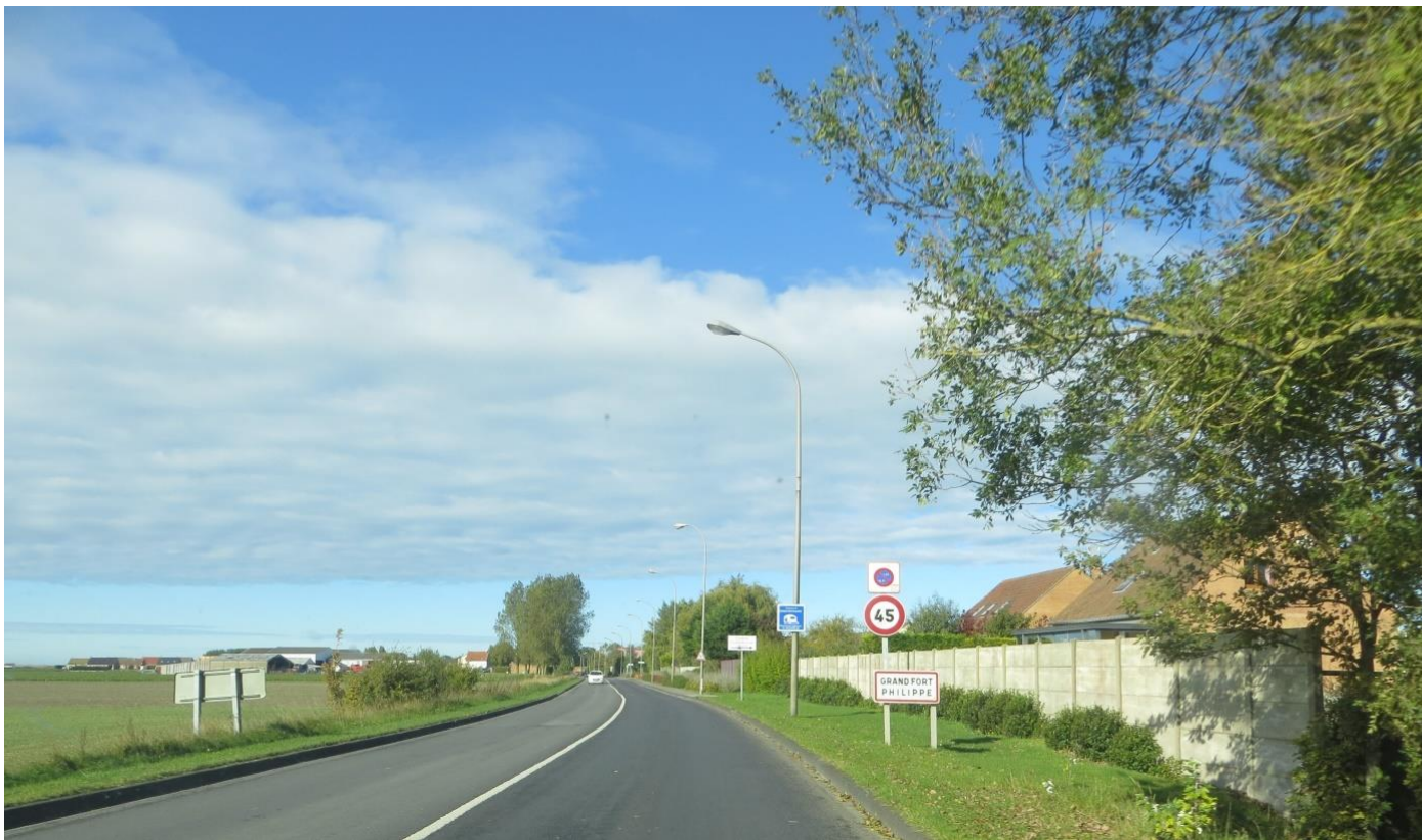
Une entrée de ville de potentiel à végétaliser, Grand-Fort-Philippe (source : Google Streetview)
