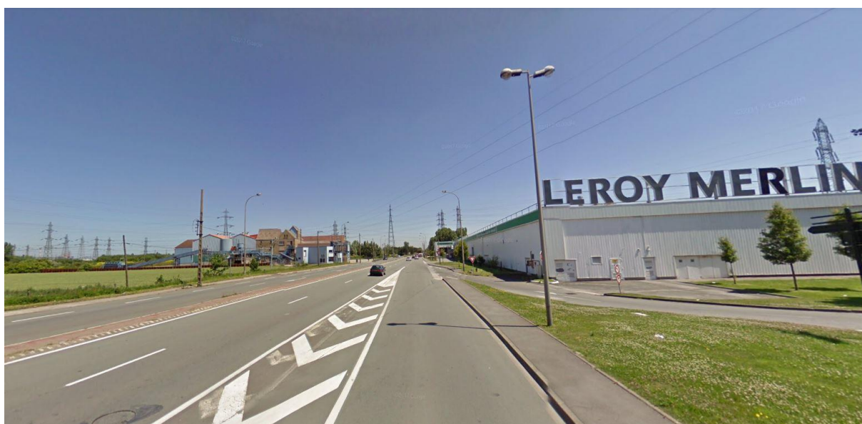
Une entrée peu qualitative à Grande Synthe : une continuité de bâti commercial imposant et non intégré dans les paysages, des lignes électriques altérant les vues lointaines (source : Google Streetview)
