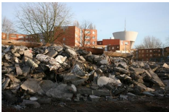
Démolitions au Banc-Vert
