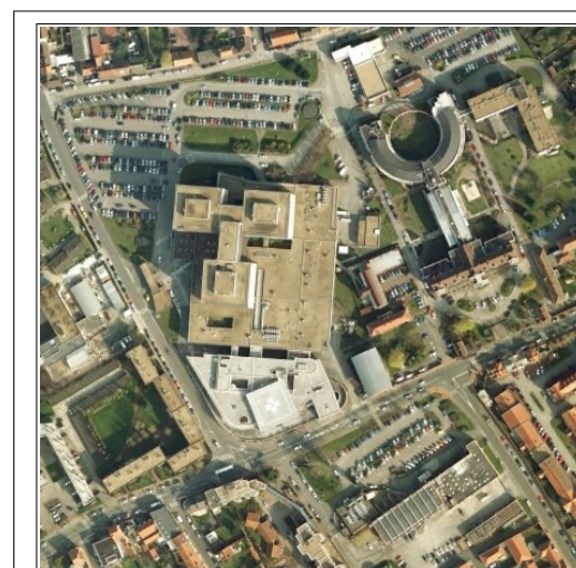
Illustration 73: Zone à grands ensembles d'équipements, Dunkerque
