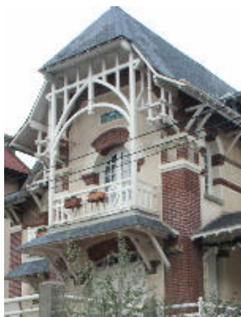
La Coquette – Charpente cintrée sur loggia
