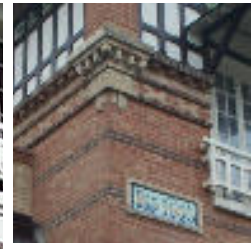
Assise en encorbellement des poteaux d'angle
