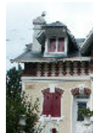
Mur de raval
