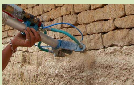
Isolation extérieure enduit chaux-chanvre
