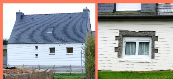
Isolation extérieure bardages PVC
