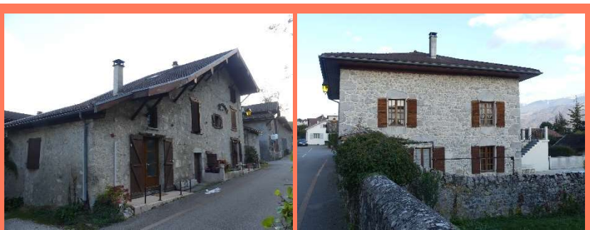
Les conduits modernes sont trop fins et incongrus dans le paysage bâti traditionnel
