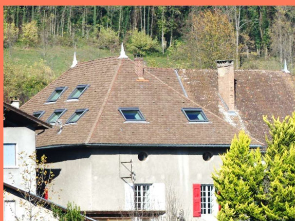
Châssis de toit en trop grand nombre Lucarnes qui paraissent disproportionnées par rapport à la façade
