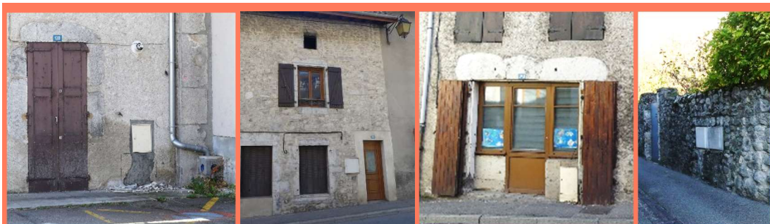
Les coffrets peuvent être cachés derrière des volets bois permettant de mieux les intégrer à la façade ou au mur
