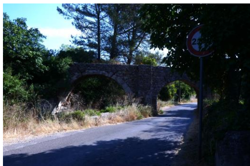
Route de Valcros et aqueduc des cinq ponts
