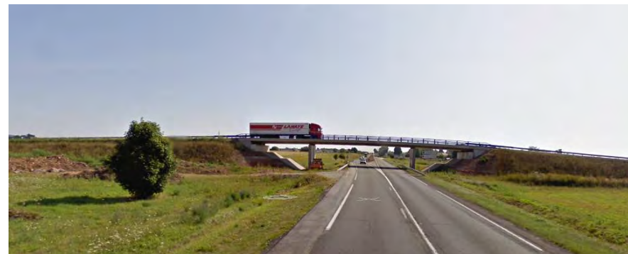
RN12, vue depuis l'échangeur en direction d'Alençon
