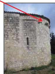
Vue du chevet - façade Sud
