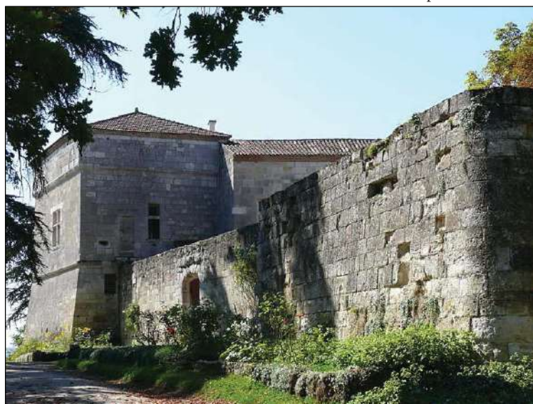
Façade Est- vue depuis l'entrée du château
