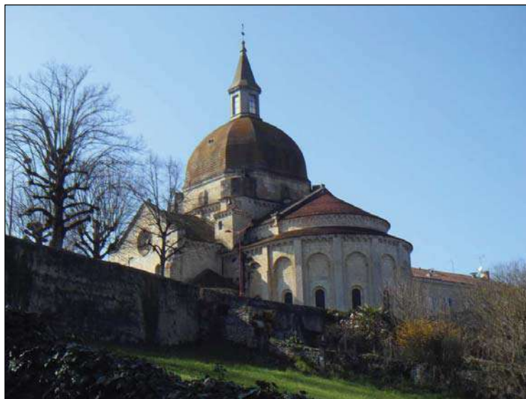
Vue de l'église à l'Est
