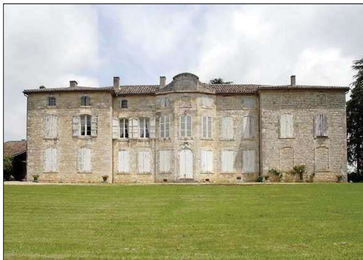
Vue sur la façade Ouest du château de Fals
