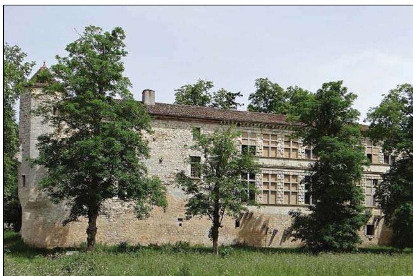
Elévation extérieure – façade Sud
