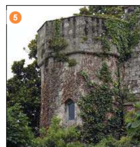
Tour du château de Montfort
