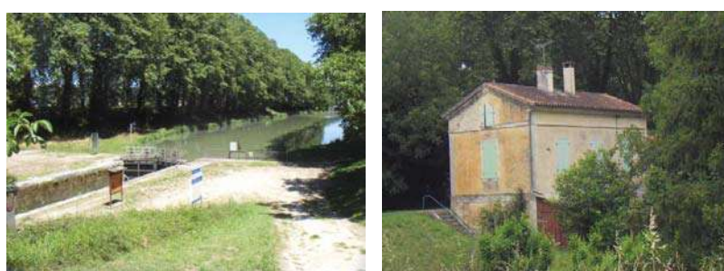
Écluse n° 37 de Rosette et sa maison éclusière et sa maison éclusière
