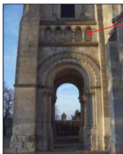
Vue depuis le porche ouvert au Sud
