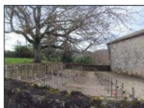
Façade Nord-côté cimetière clos attenant à l'église
