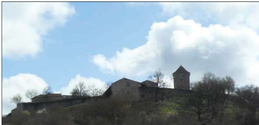
Vue sur l'ensemble du château de Roquefort au Nord-ouest
