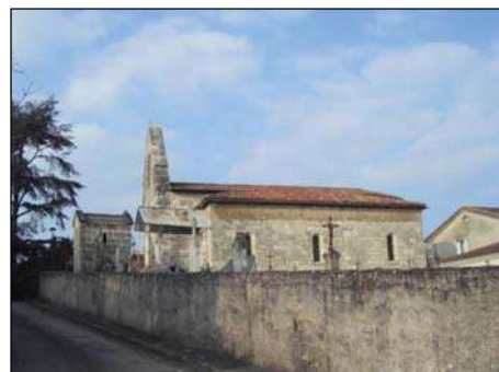
Vue depuis le cimetière- façade Sud
