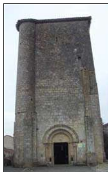
Vue de la tour-clocher
