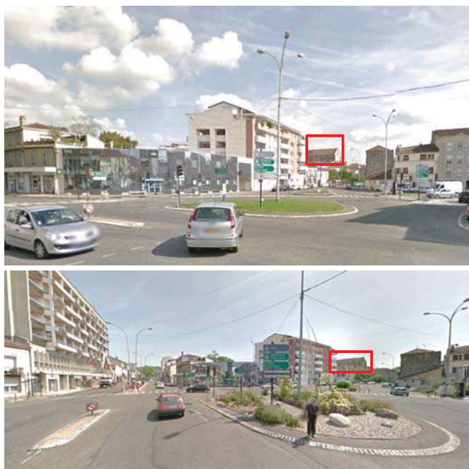
Façade Nord de la place Eugène Pelletan
