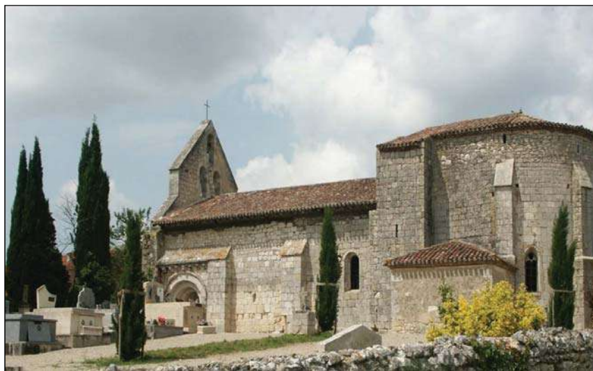
Elévation extérieure-Vue Sud de l'église
