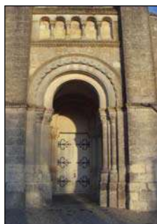
Vue du porche et du portail-façade orientale
