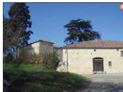
Vue sur la dépendance et le corps de logis du château (à gauche)
