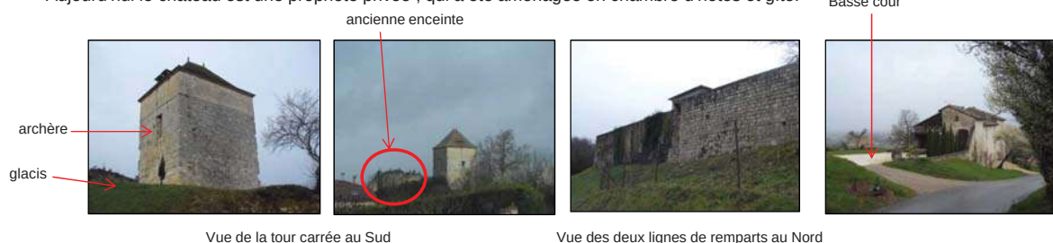
Vue de la tour carrée au Sud
