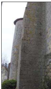
Vue d'un contrefort
