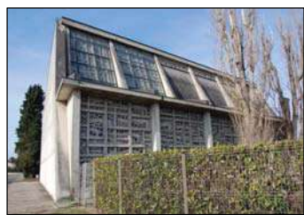
Vue sur la partie Est de l'église avec ses vitraux en verre éclatés
