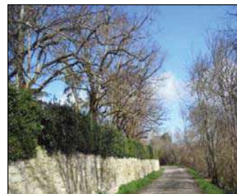
Mur de soutènement du parc en pierres sèches
