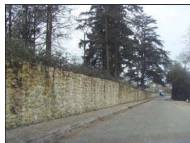
Mur de soutènement du parc, en remontant vers l'entrée du village
