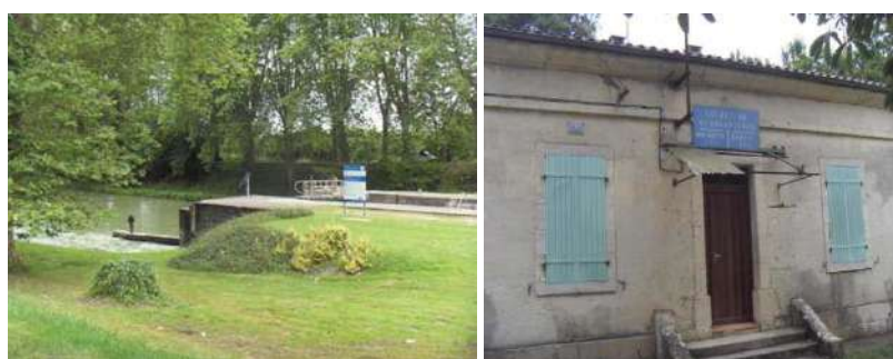
Écluse n° 36 de Chabrières et sa maison éclusière
