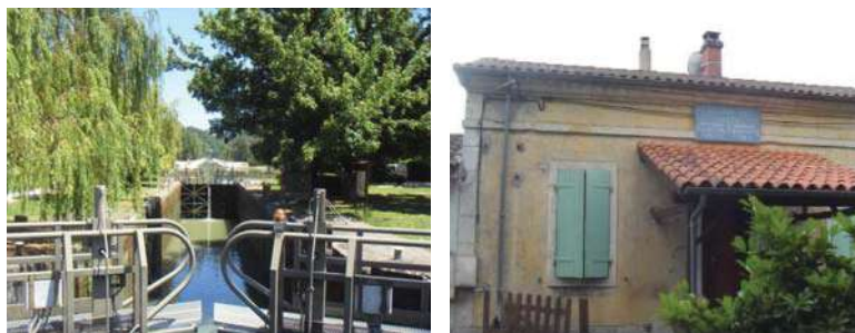
Écluse n°34 d'Agen et sa maison éclusière
