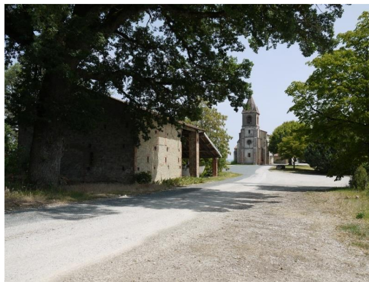
Photographie 4 : Ferme et espace public à Pratviel
