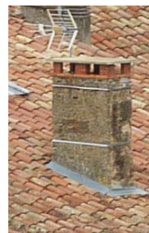
A FAIRE : conserver ou réaliser des souches de cheminées de section rectangulaire.
