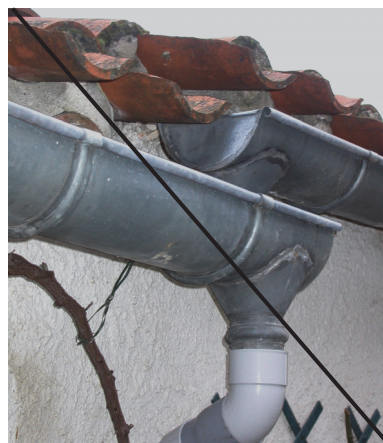
A PROSCRIRE : les raccords et les éléments en PVC, les descentes hétérogènes
