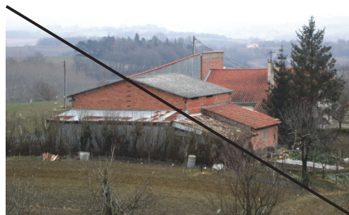
A PROSCRIRE : L'utilisation des matériaux type éverite pour les toitures.
