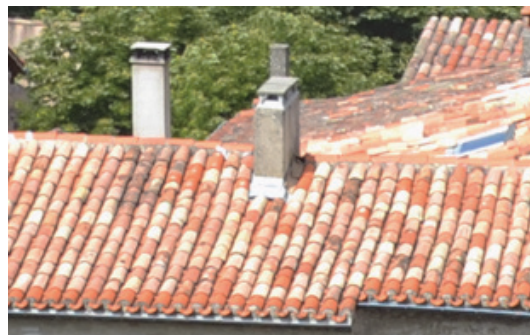
A FAIRE : souche de cheminée de section rectangulaire recouverte d'un chapeau plat.
