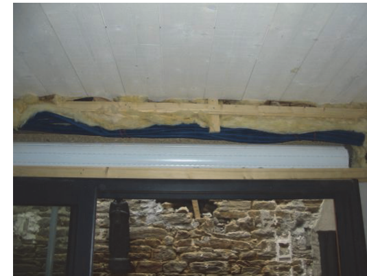
A FAIRE : intégrer dans l'isolation intérieure les coffres de volet roulant.
