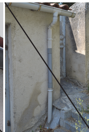
A PROSCRIRE : les raccords et les éléments en PVC, les descentes hétérogènes
