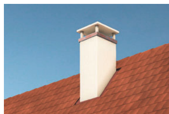
A FAIRE : souche de cheminée de section rectangulaire recouverte d'un chapeau plat.
