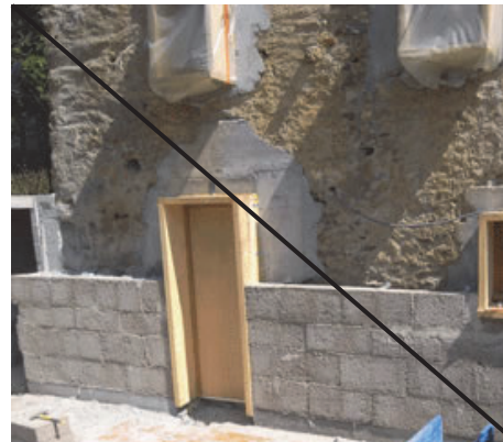
A PROSCRIRE : réaliser une isolation par l'extérieur sur un bâti ancien.
