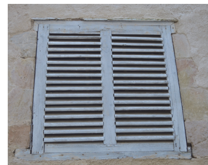
A FAIRE : peindre les volets sans utiliser de peinture brillante, et en accord avec le nuancier RAL (ici RAL 7035).
