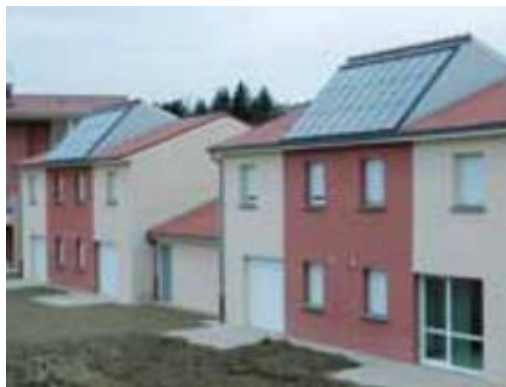
> Couverture totale en capteurs solaires thermiques (Chauffage)
