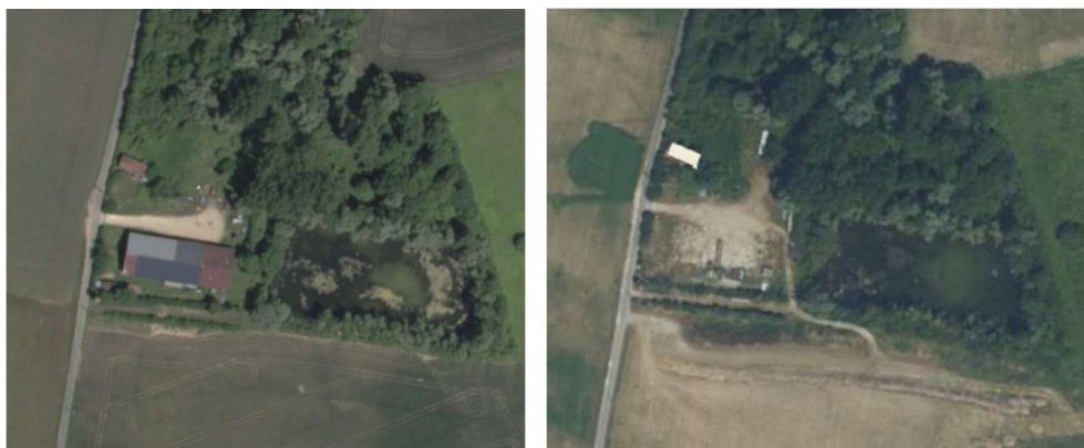
Vue du terrain et de l'ancien hangar (photographie 2013 et 2022)
