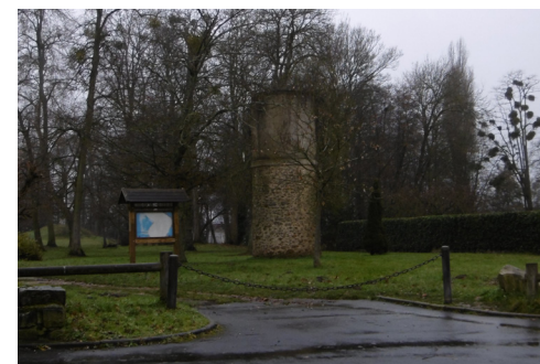
53 Réservoir du parc de Farcy
