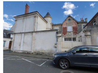
Même bâtiment façade rue Lambert Licors
