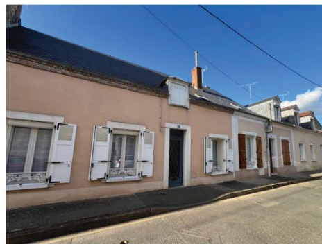
bâtiments de faubourg et dunois couverture en petites tuiles plates de terre cuite
