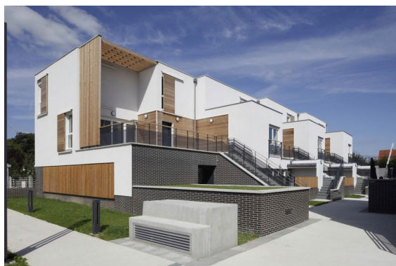
Montfermeil. Caradec & Risterucci architectes © Hervé Abbadie
