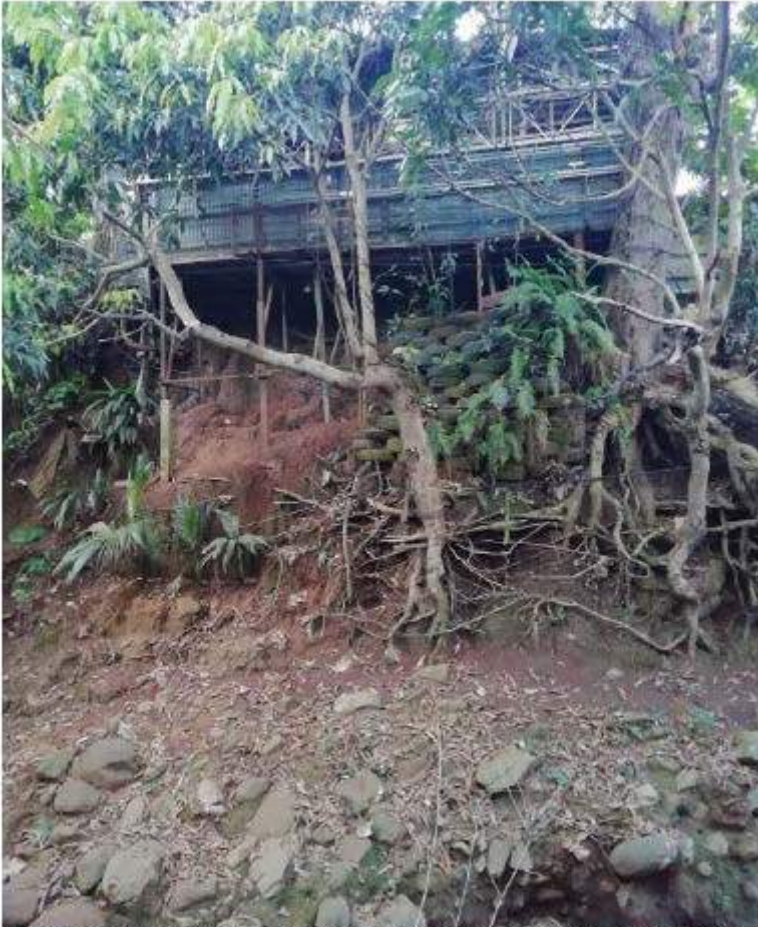
l'érosion des berges fait apparaître les racines en partie aval - octobre 2018
