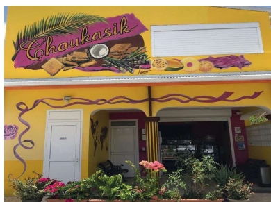
Lettres peintes sur enduit
