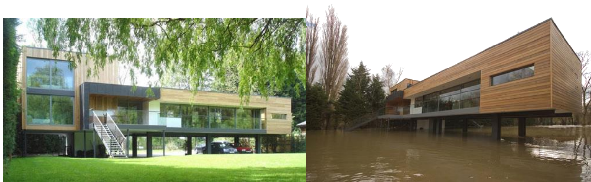
Figure 10 : Exemple d'adaptation de l'habitat au risque inondation dans un axe de ruissellement en Angleterre
