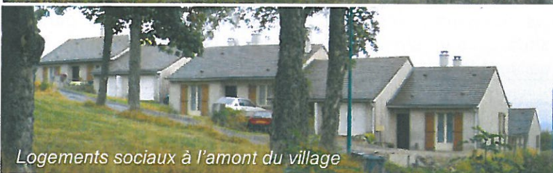
Pavillons à l'amont du village
