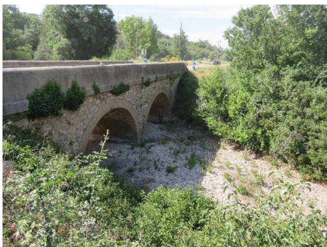
Pont permettant le passage de la RD225 au-dessus du Ruisseau de Goutajon
