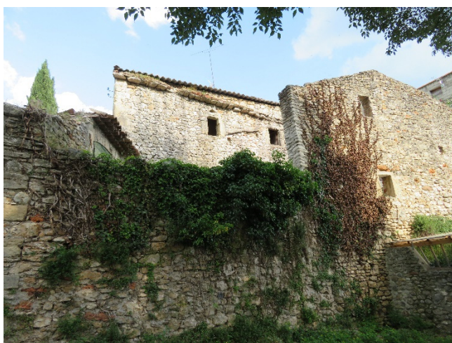
Bâti abandonné et mur végétalisé dans le cœur du village
