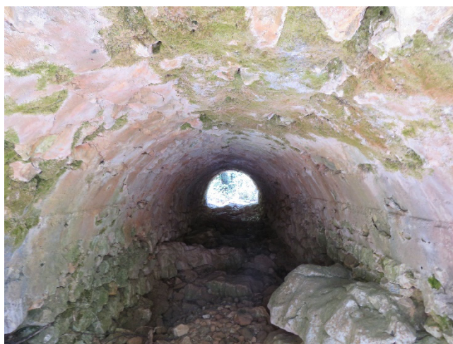
Tunnel sous une piste pour l'écoulement du Ruisseau d'Aigues-Vives
