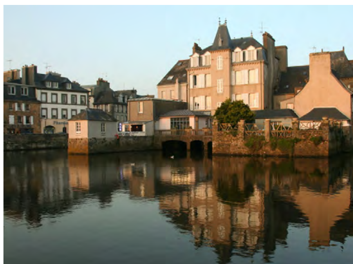
Pont de Rohan, Landerneau
