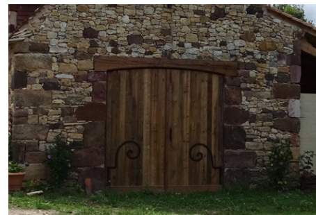
Porte d'ancienne grange rénovée avec soin (Grives)
