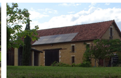
Bonne intégration paysagère sur une gange ancienne : panneaux solaires et encadrement gris très foncé, proportionnés et regroupés dans l'alignement de la porte cochère en bas de pente (Coux-et-Bigaroque-Mouzens)
