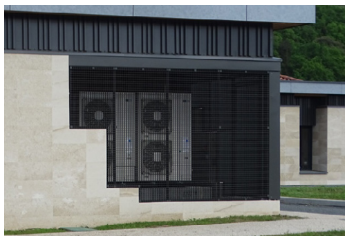
Intégration des blocs de climatisation (St Cyprien)
