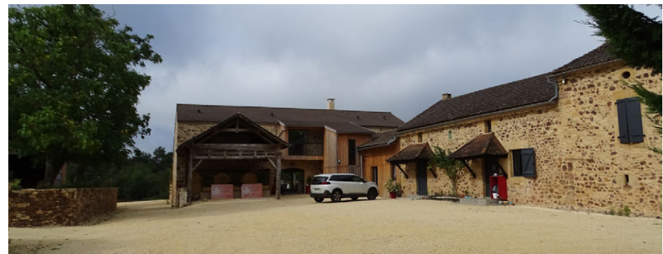
Ici aussi, rénovation et extension du bâti ancien réalisées avec soin : respect des pentes de toit, uniformité des matériaux de toiture, volumes simples et proportionnés, bardage bois et ouvertures pour les touches contemporaines, Pays de Belvès
