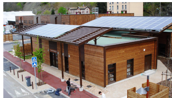
Panneaux solaires intégrés dans la composition du bâtiment
