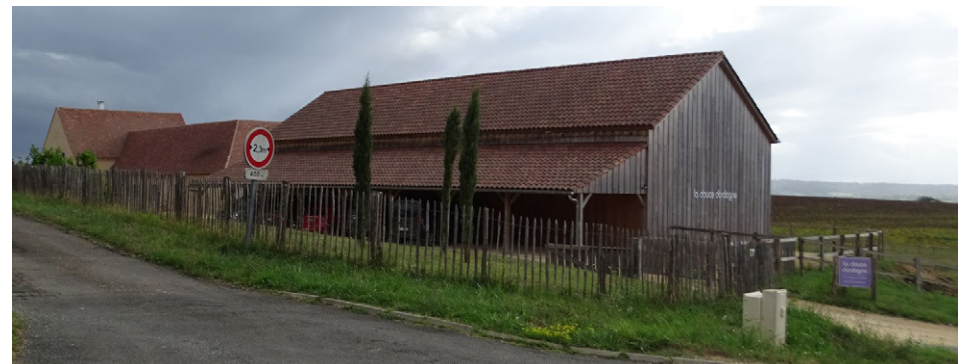
Bâtiment de qualité reprenant la forme des anciennes granges-étables, toiture en tuile canal, léger décroché de toiture pour la création d'un préau, bardage en bois grisé qui confère une touche contemporaine à la construction (Coux-et-Bigaroque-Mouzens)
