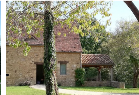
Extensions respectant la construction d'origine : volume proportionné, pentes et couverture des toitures, colombage en bois, couleur d'enduit (qui semble en terre ou à la chaux), prolongement de muret en pierre de pays..., Larzac (source : google maps)
