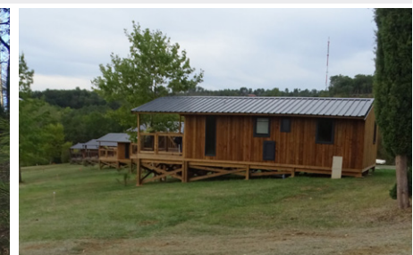
Adaptation à la pente par des plots en bois, encadrement de fenêtre et toiture sombres (Coux-et-Bigaroque-Mouzens)
