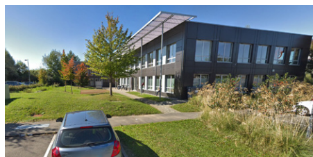
Végétalisation généreuse et soignée (Villeneuve d'Ascq, 59 - Source : Google street view)
