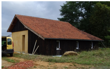
Exemples de façade mixte maçonnerie / bois (Coux et Bigaroque Mouzens, Carves)
