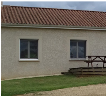
Volets roulants avec coffres intégrés dans le mur (Doissat)
