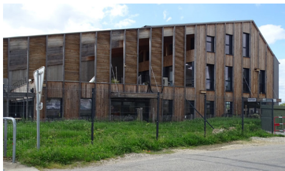
Bâtiment d'activité très soigné : toiture à pans dissymétriques proportionnés, bardage bois jouant avec l'orientation des planches, répartition régulière des ouvertures... jusque dans le détail du portillon d'entrée (Chabeuil, 26)
