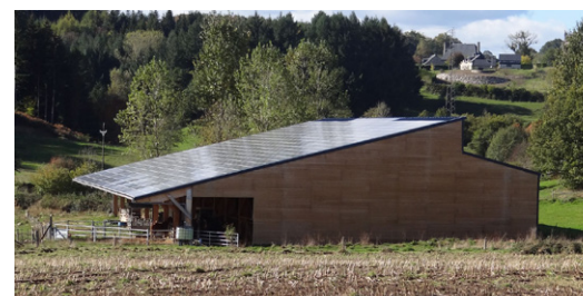
Toiture photovoltaïque sur une pente adaptée (Neuvic, 19)
