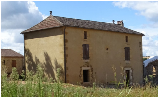
Enduit rénové dans les tons attendus par le règlement (Sainte-Foy de Belvès)
