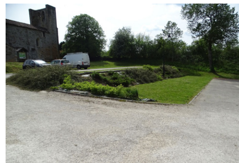
Stationnements entièrement perméables et traités en terrasses pour s'adapter à la topographie(Larzac)
