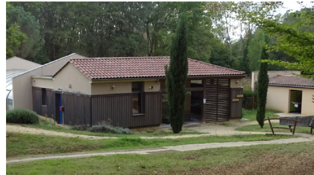
Construction respectant les principes du règlement : pente de toiture et couverture, couleur de l'enduit dans la partie maçonnerie, bardage bois (Coux-et-Bigaroque-Mouzens)
