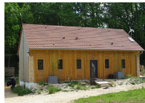
Pente de toit et couverture adaptés, façade qualitative (Marnac)
