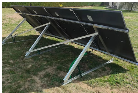
Exemple de système de supports autorisés dans les espaces de pleine terre (source : https://www.solarcoop.fr )
