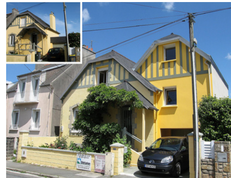
Exemple d'extension latérale plus haute que la construction principale avec une accroche au bâtiment existant réussie : rappel de toiture et de façade (source : Batiplan)
