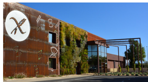
Matériaux bruts et association végétale (Entraigues/Sorgues, 84 - source : Biovence)
