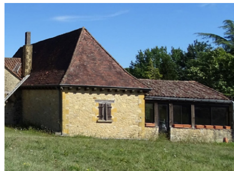
Véranda bien intégrée par un soubassement reprenant l'aspect de la façade principale, une toiture à 2 pans couverte en tuile canal, encadrement de baies en bois et menuiseries sombres (Saint-Germain de Belvès)
