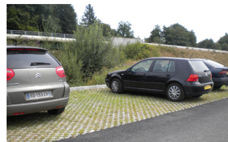
Stationnement perméable et végétalisation du parking (Malemort, 19)
