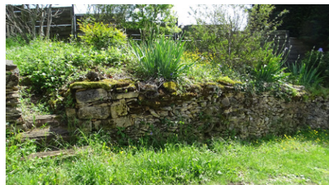
Muret de soutènement en pierre sèche (Carves)
