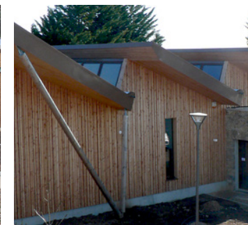
Pente de toiture étudiée pour implanter des panneaux solaires de façon optimale
