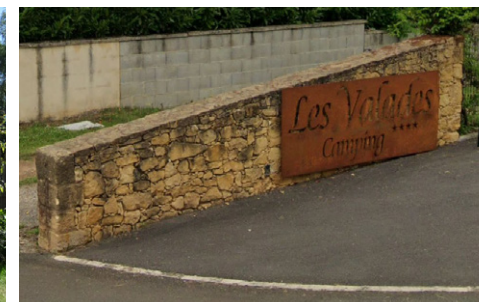
Mur d'entrée en pierre de pays (Coux-et-Bigaroque-Mouzens)
