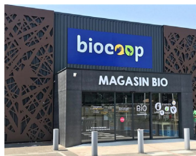
Bardage métallique sombre doublé par un motif (Bergerac - source : ADP Enseignes)
