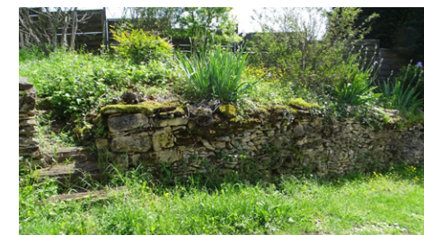
Muret de soutènement en pierre sèche (Carves)
