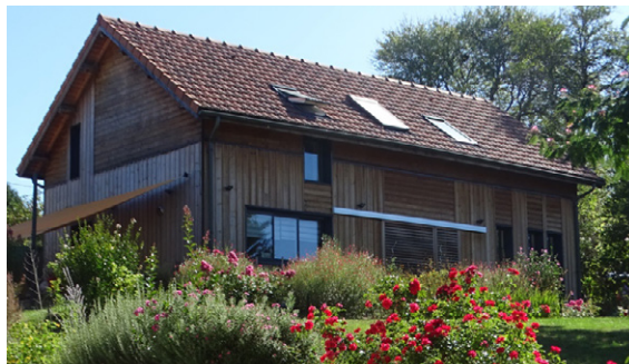
Menuiseries contemporaines cohérentes sur l'ensemble de la façade (Meyrals)
