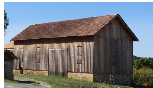
Transformation d'un ancien séchoir à tabac en logement : bardage en bois et percements verticaux pour les ouvertures en rappel de l'origine de la construction (Monplaisant)
