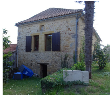
Fenêtre créée avec soin : cohérence sur la façade, pierres d'encadrement, menuiserie sombre... (Sainte-Foy de Belvès)
