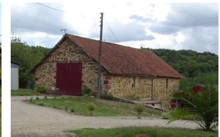
Implantation perpendiculaire à la pente permettant des accès directs aux 2 niveaux (Doissat)
