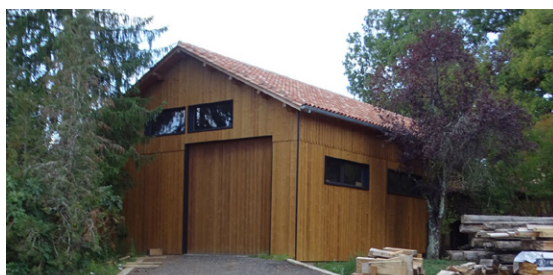
Entrepôt artisanal à Castels et Bézenac : forme simple, bardage en bois, toiture en tuile romane, gouttière en zinc...
