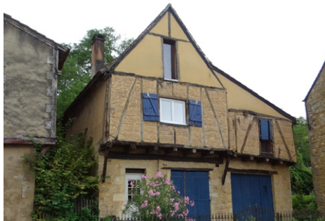
Colombage avec brique et enduit couvrant (Sagelat)
