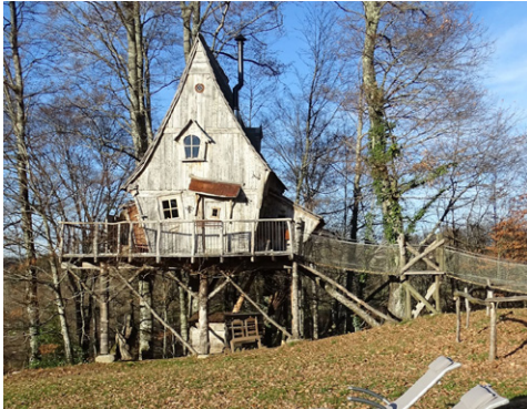
Hébergement construit avec des matériaux de réemploi (Sexcles, 19)
