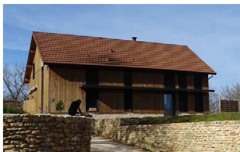
Construction neuve faisant écho aux anciens séchoirs à tabac dans une interprétation contemporaine (Meyrals)
