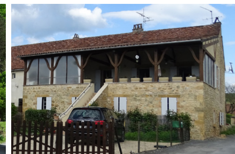
Façade maçonnerée dans le respect du nuancier pour les enduits (Saint-Cyprien)
