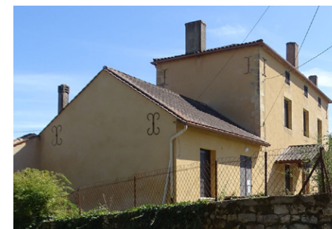
Bonne intégration de l'extension par l'usage de la tuile romane et l'homogénéité de l'enduit (Monplaisant)
