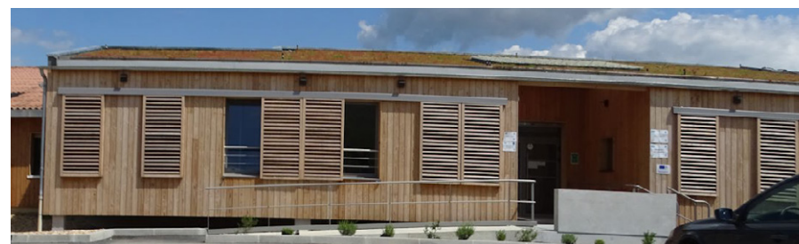
Bardages en bois, gouttière en zinc, ouvertures régulières, toiture végétalisée, accès PMR bien intégré : laiterie (Saint-Cyprien)
