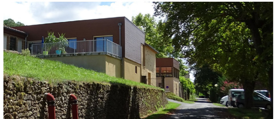
Extension et requalification dans l'esprit de constructions anciennes à Sainte-Foy de Belvès
