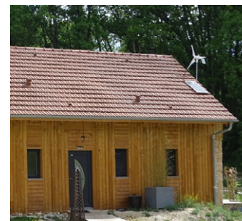
Exemples de bonne intégration d'une petite éolienne domestique (Marnac)
