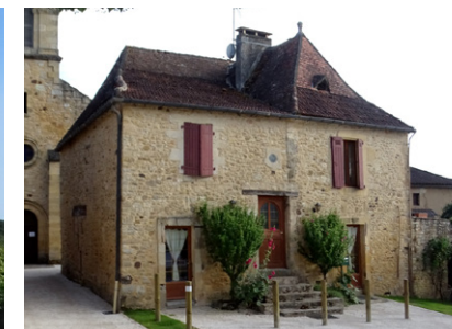
Rénovation d'une maison de ville : enduit dans les tons du village, porte d'entrée et porte fenêtre en harmonie, (St Germain de Belvès)
