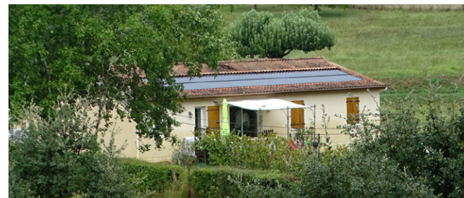
Bonne intégration paysagère : panneaux solaires et encadrement gris très foncé, pose dans l'épaisseur de la couverture (Coux-et-Bigaroque-Mouzens)
