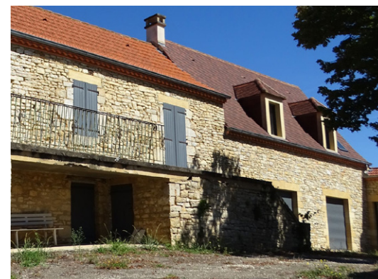
Extension réussie grâce à l'homogénéité de la façade et des encadrements de baie, l'utilisation de petites tuiles plates de teinte rouge vieilli en toiture et le rang de génoises (Cladech)
