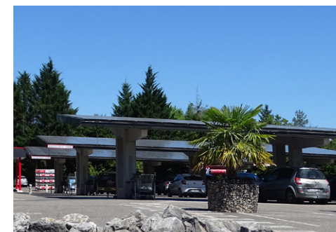
Ombrières photovoltaïques à Martel, 46
