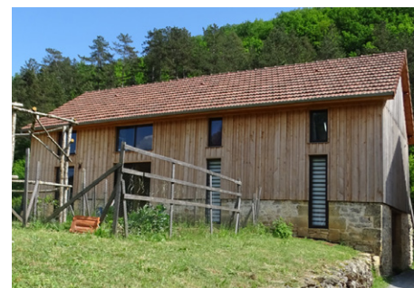
Rénovation d'ancien séchoir en logement associatif pierre et bardage en bois (Castels)
