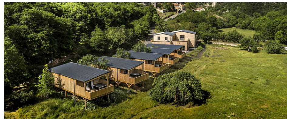
Hébergements implantés à l'appui d'un boisement et suivant les courbes de niveau ; construits sur pilotis et dans une démarche écologique forte ; leur proximité les uns des autres n'exclut pas les espaces d'intimité créés par leur agencement (Torsiac, 43 - source : https://www.auvergne-destination.com ) Attention, les toitures sont ici noires car le projet se situe en Auvergne.
