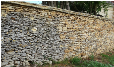
Prolongement (teinte plus jaune) d'un mur en pierre sèche avec couronnement (Castels et Bézenac)
