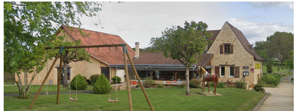
Extension de bâtiment et jonction par une véranda dans le respect des bâtiments existants : légère cassure du pan de toit de l'extension et enduit dans la couleur des joint de la partie d'origine, accroche sur les bâtis existants, jeu avec le type de tuile (la tuile canal fait liaison entre la petite tuile plate et la tuile mécanique), Meyrals (source : google maps)
