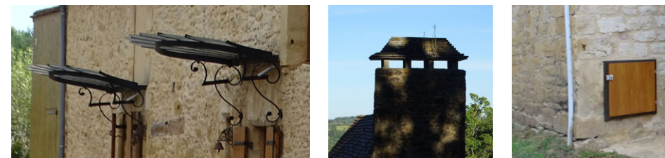
Marquises, cheminée, coffrets techniques, autant de détails qui participent à la qualité des façades
