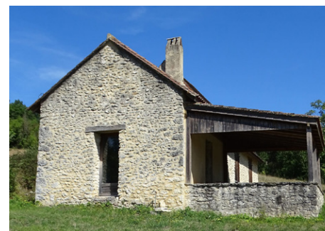
Bonne intégration de l'extension par l'usage du bois, de la pierre de pays et de la tuile romane (Marnac)
