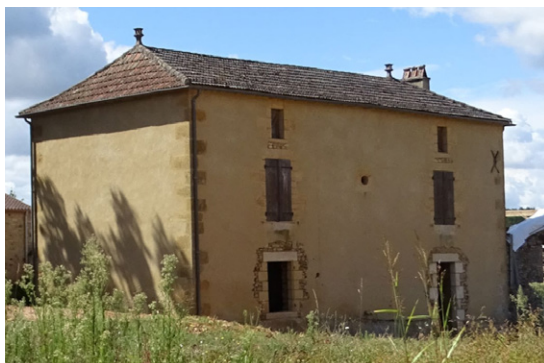
Enduit rénové dans les tons attendus par le règlement (Sainte-Foy de Belvès)
