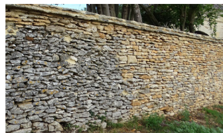
Prolongement (teinte plus jaune) d'un mur en pierre sèche avec couronnement (Castels et Bézenac)
