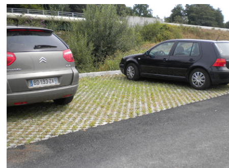
Stationnement perméable et végétalisation du parking (Malemort, 19)
