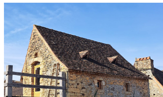
Toiture rénovée avec soin : petites tuiles plates, maintien des pentes (Coux et Bigaroque Mouzens).
