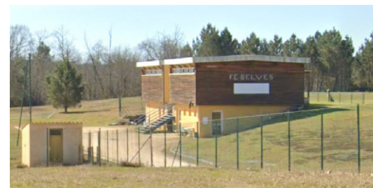
Vestiaires du stade de Pays de Belvès : prise en compte de la topographie, rénovation des façades avec un bardage bois et des enduit ocre jaune pour la partie basse maçonnée
