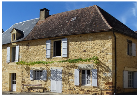
Façade en pierre et joints à la chaux (St-Germain)
