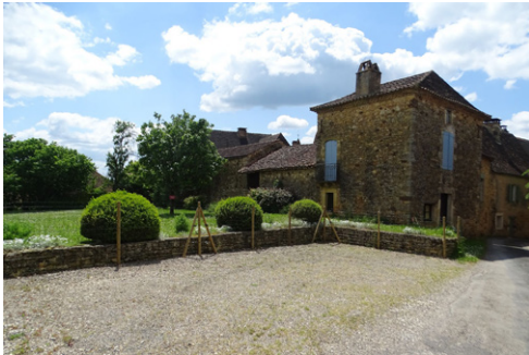
Exemples de stationnement perméable en gravillons (Saint-Germain de Belvès)
