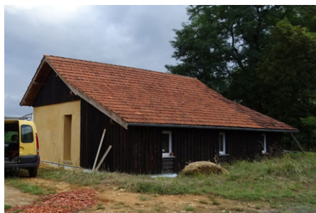
Exemples de façade mixte maçonnée / bois (Coux et bigaroque Mouzens, Carves)
