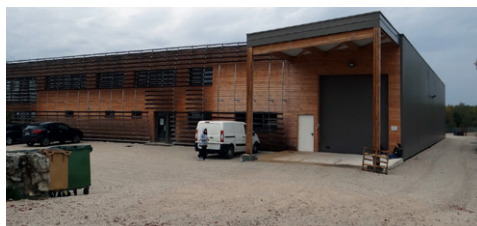
Sols entièrement perméables (Rignac, 46)
