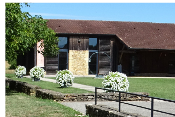
Transformation d'une grange étable en équipement culturel : interprétation soignée de la porte charretière (Meyrals)
