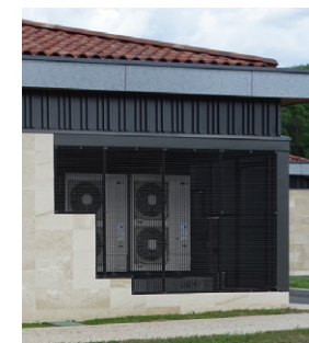
Intégration des blocs de climatisation (St Cyprien)
