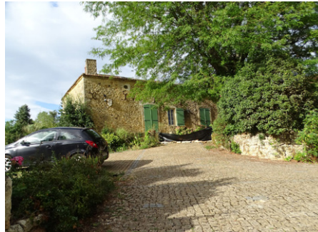
Exemples de stationnement perméable en pavé (Doissat)
