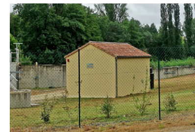
Bâtiment technique de la station d'épuration de Pays de Belvès : toiture 2 pans avec tuile canal, enduit ocre jaune
