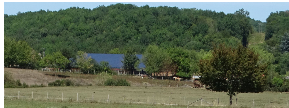
Panneaux solaires en toiture qui s'intègre dans le paysage : pose homogène sur toute la toiture, encadrement et panneau de la même couleur (Saint-Cyprien)
