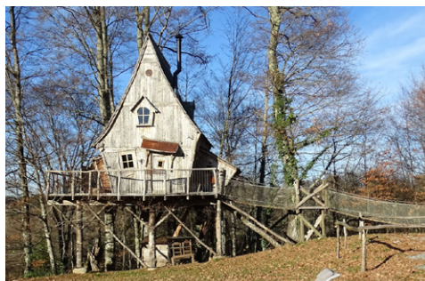
Hébergement construit avec des matériaux de réemploi (Sexcles, 19)
