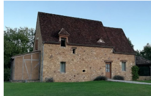
Extensions respectant la construction d'origine : volume proportionné, pentes et couverture des toitures, colombage en bois, couleur d'enduit (qui semble en terre ou à la chaux), prolongement de muret en pierre de pays..., Larzac (source : google maps)
