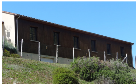
Rénovation de la salle des fêtes combinant enduit en soubassement et bardage bois (Marnac)
