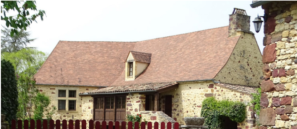
Exemple de toiture peu adaptée pour recevoir des panneaux solaires : qualité patrimoniale de la construction et pente de toit trop forte. Une implantation en partie basse ou sur l'extension en avancée pourrait éventuellement convenir selon les types de panneaux et la qualité de pose (Grives).
