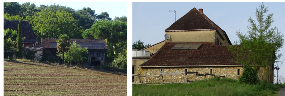
Exemples de panneaux solaires bien intégrés en toiture (Grives, Carves)
