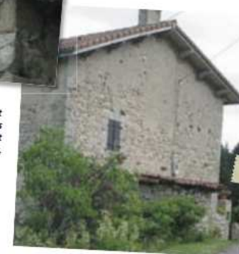
Les murs pignons peuvent être également protégés par un débord de toit portée par des pannes.
