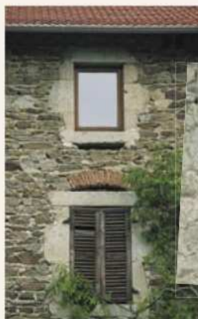
Les ouvertures de petites taille peuvent être traitées par un chassis à simple carreau.
