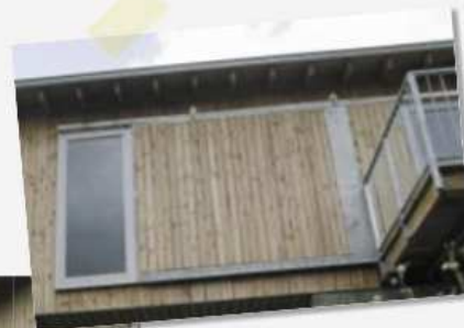
Les volets coulissants sur un rail associent bois et fer pour une mise en œuvre simple et économe inspirée des ateliers de coutellerie de la région.
