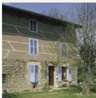
Chaîne d'angle en harpage.
