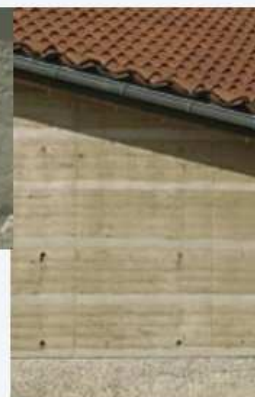
Le mur en pisé de cette grange en ruine a intégralement été reconstruit avec la terre récupérée sur le site.
