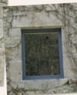
L'aluminium peint, l'acier, sont aussi envisageables en réhabilitation et permettent d'avoir des menuiseries de section inférieure.
