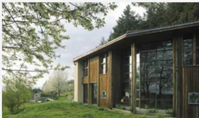
La façade sud de la maison est réalisée en bois et verre, encastrée entre deux murs pignons en maçonnerie traditionnelle.
