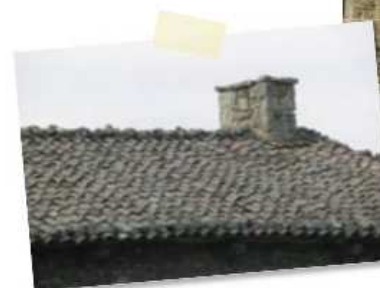
Les souches de cheminée sont massives, réalisées en pierre ou en brique.
