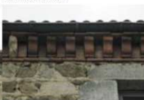
Corniches à modillons.
