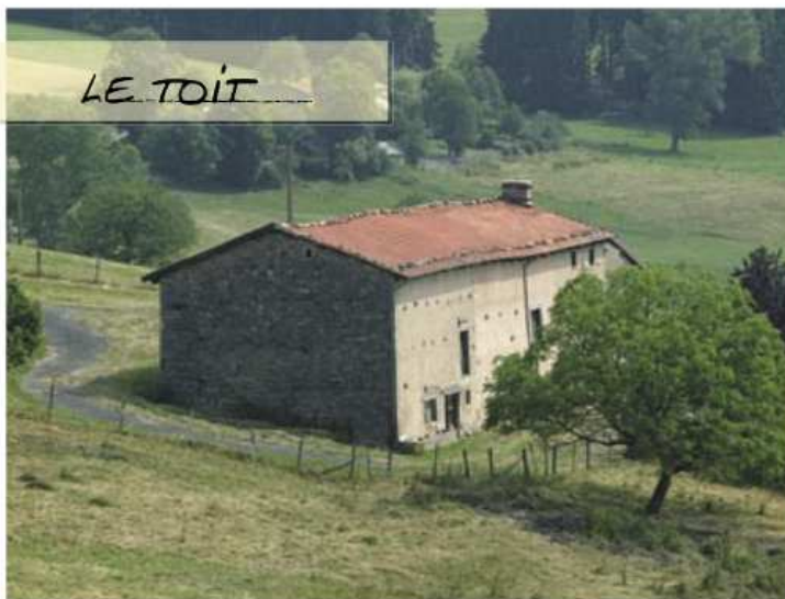
Des tuiles creuses en terre cuite rouge sont utilisées en couverture, maintenues par des pierres sur les ouvrages plus sensibles au vent : le faîtage, les bords de toit.
