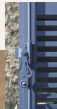
Une seule couleur pour les volets (bois et éléments de quincaillerie) simplifie la perception de la façade.
