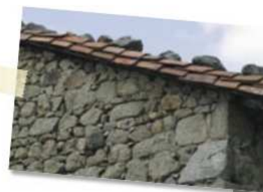
Les murs pignons peuvent être également protégés par un débord de toit portée par des pannes.
