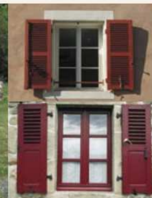
A l'étage les volets sont persiennés et permettent, en période estivale, de ventiler un espace intérieur tout en conservant un minimum de clarté.
