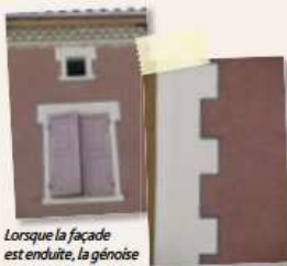
Chaîne d'angle en harpage.
