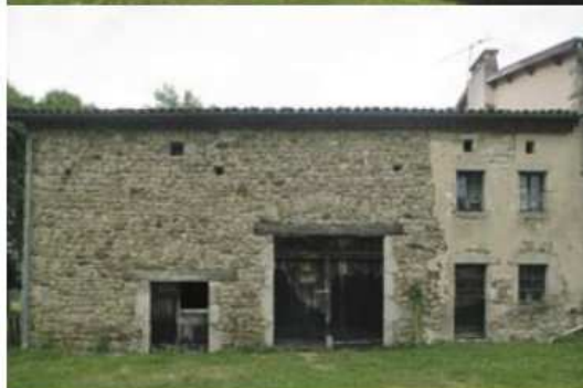
Un enduit léger, sans badigeon de couleur, protège le logement. La grange et l'étable ne sont pas enduites.
