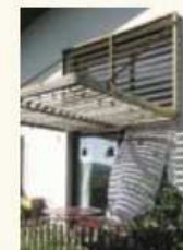
Une large ouverture apporte de la lumière et des vues sur le paysage. Elle est ici protégée du rayonnement par un système de pare-soleil en bois qui se déploie également au-dessus de la terrasse.
