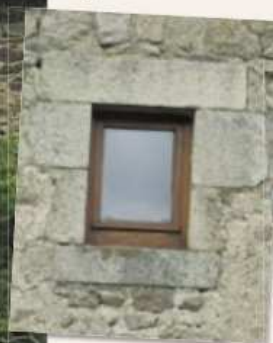
Les ouvertures de petites taille peuvent être traitées par un chassis à simple carreau.
