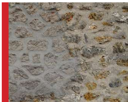
Mise en œuvre de joints en ciment gris recouvrant partiellement les moellons*.
