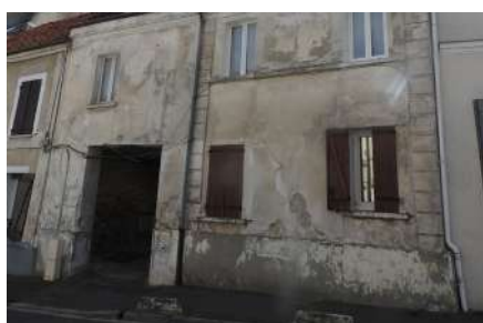
Enduit ancien au plâtre et corniche en plâtre qu'il serait souhaitable de restaurer.
