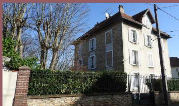
À gauche meulière recouverte de ciment et à droite enduit au ciment masquant la pierre.
