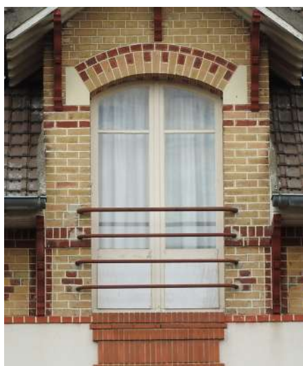
Menuiseries cintrées d'origine conservées.
