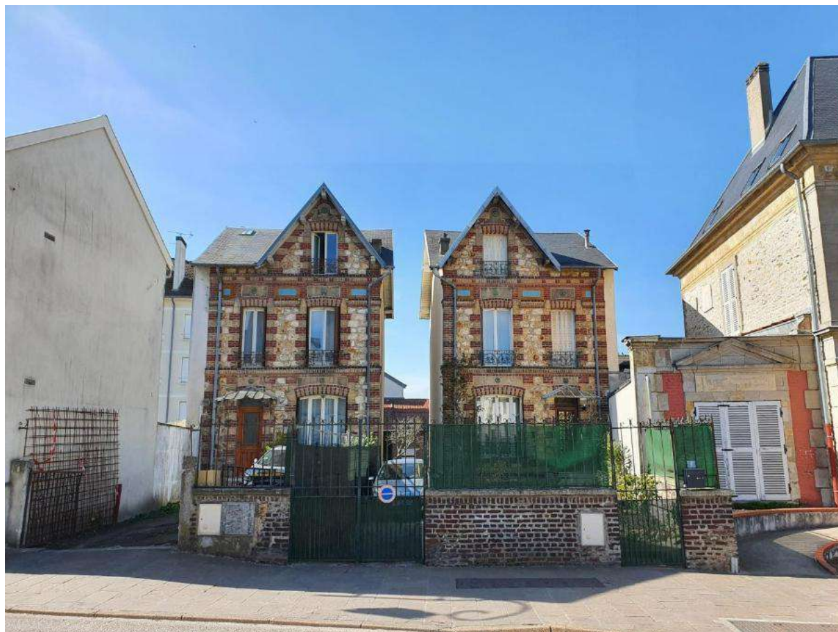
AV80 - 9 rue de la Mairie
