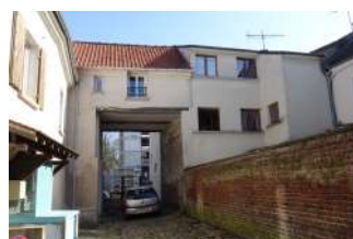
Vue arrière d'un porche
