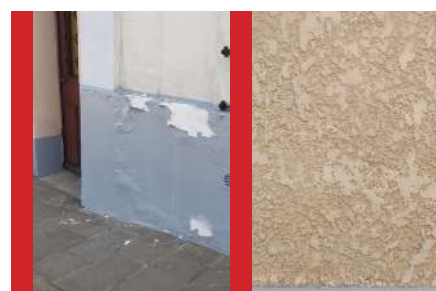
Enduits plastiques à proscrire : ils ne permettent pas les échanges thermiques, sont très uniformes, possèdent une finition inadaptée et le plus souvent masquent les anciens décors.
