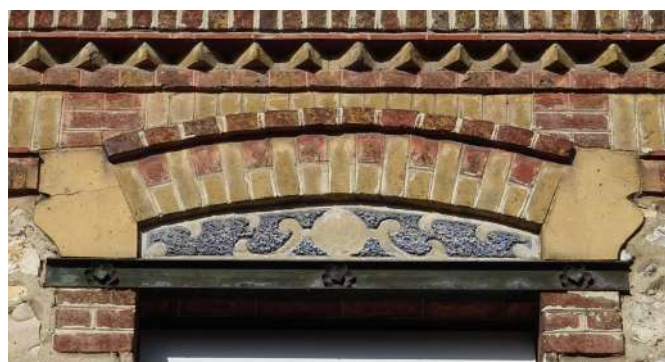
Linteau métallique surmonté d'un décor en ciment prompt
