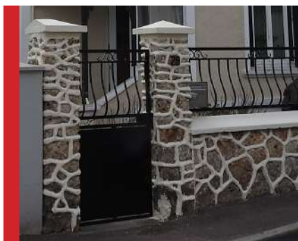
Mise en œuvre de joints trop larges et trop en relief à éviter.
