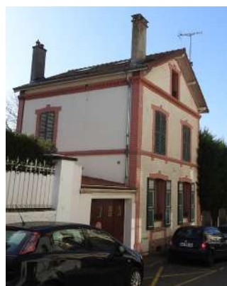
Maison alignée avec la rue
