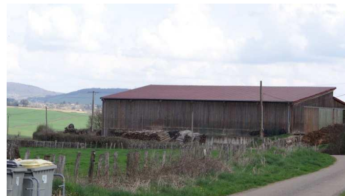
Par rapport à un bâtiment en parpaings « classique » le bardage bois permet de mieux intégrer le volume dans le paysage (teintes, aspect)
