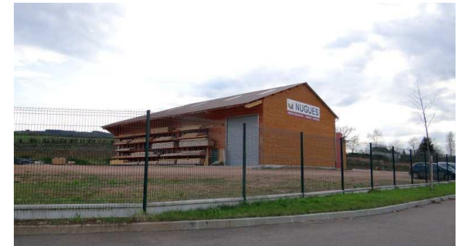
À Genève-Océan, le bâtiment en bardage et la clôture soignée donnent de la qualité à la zone
