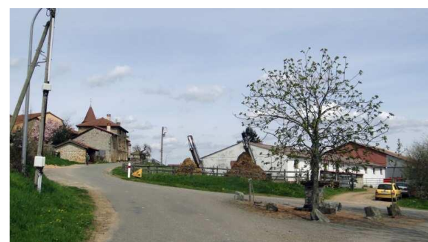
A Montagny l'arbre qui sert de rond-point marque efficacement l'entrée même si celle-ci pourrait encore être aménagée
