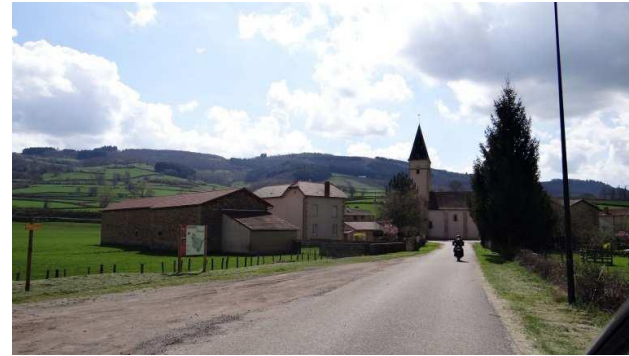
À Clermain, l'Église est mise en scène par l'alignement des quelques bâtiments. Cette vue pourrait être perturbée par du pavillonnaire sans structure
