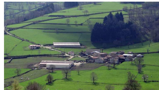
Les hangars agricoles étirent artificiellement le paysage du hameau
