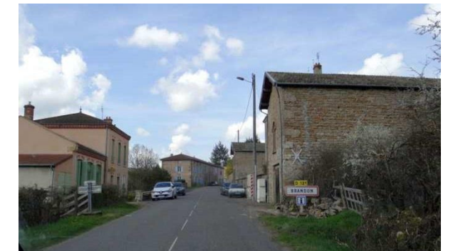
A Brandon, l'alignement des façades est typiquement villageois
