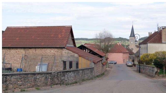
Murets à l'entrée Sud de Vérosvres
