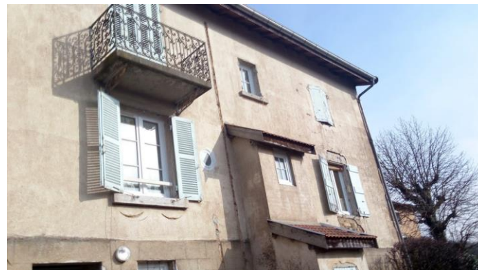
Immeuble de l'OPAC71 à Saint-Pierre-le-Vieux – Photo Trajectoires
