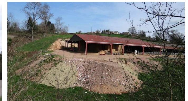
Le terrassement du bâtiment a généré de forts talus difficiles à intégrer au paysage
