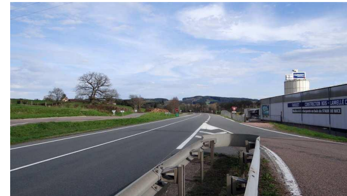
Entrée Nord par la RCEA qui longe la zone d'activités de Chevannes
