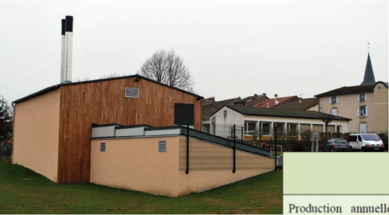
Chaufferie bois de Matour
