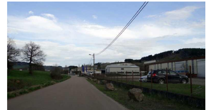
À Genève-Océan, une partie des clôtures n'est pas encore normalisée
