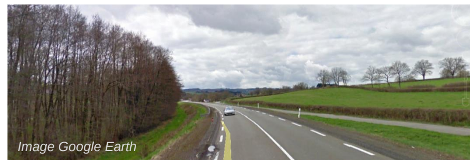
Les premières perceptions sur le site au niveau des bassins de rétention
