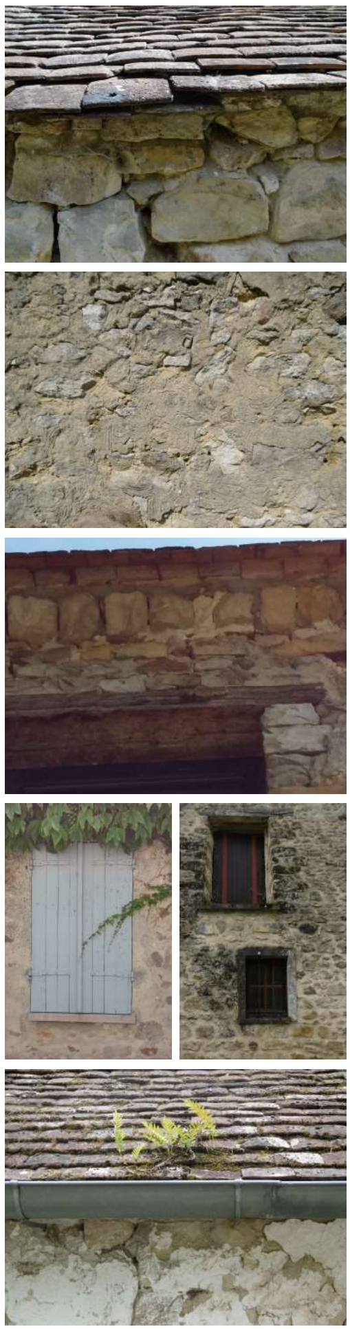
La principale cause de désordres réside dans les infiltrations d'eau, quelles relèvent de remontées capillaires, de disjonctions entre les différents matériaux et éléments constituant la maçonnerie, les menuiseries ou la couverture.
