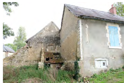
Bâti ancien à rénover entre la motte castrale et la Creuse.
