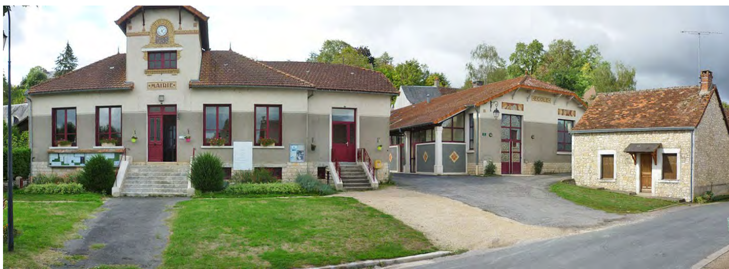
L'ensemble bâti autour de la mairie vu depuis la place de l'église. L'ensemble Mairie-école, construits entre 1934 et 1936 constitue un beau patrimoine de l'architecture du XX e siècle.
