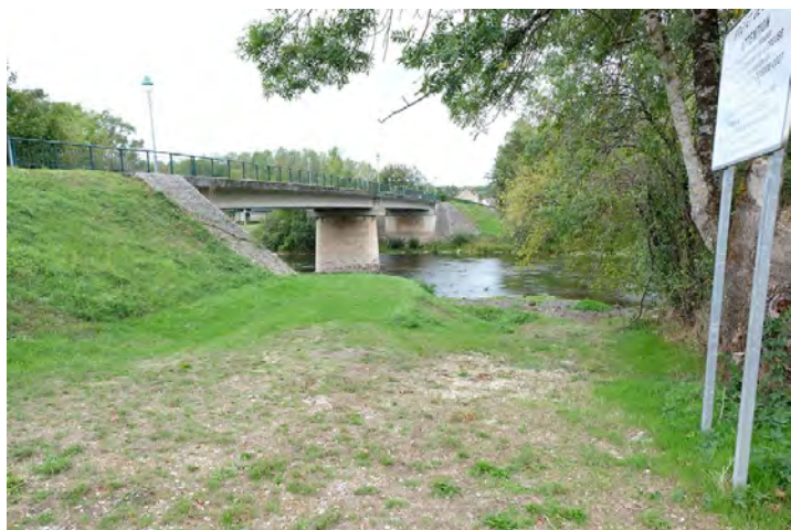
Le pont surplombant la Creuse et l'accès à la Creuse.
