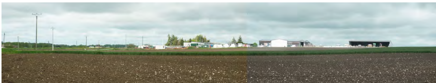
Le site vu depuis l'est, à l'entrée du hameau de la Borde : des installations qui banalisent les paysages remarquables des vallées du Suin et du Mortalanes.
