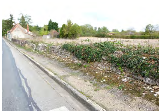
RD15 - Les restes d'un beau muret en pierre sèche à préserver et à restaurer dans l'opération d'aménagement de ce secteur.
