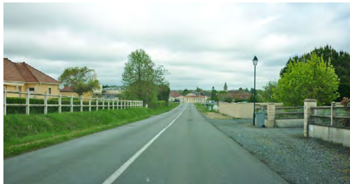
Le long de la RD17, au niveau des premiers pavillons en direction de Douadic. (avril 2019)
