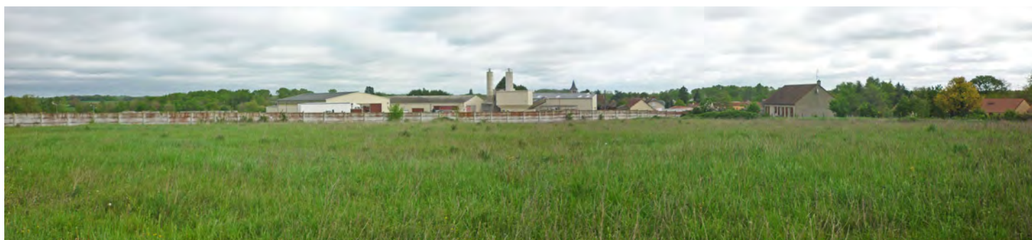
Entrée-sud de Douadic : arrière de l'usine, chemin du tour de ville. (avril 2019)
