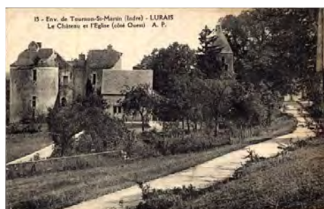
Le Château et l'Eglise (côté ouest)
