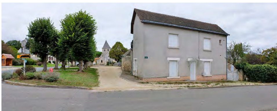
Carrefour RD50/RD95 - Vue vers le nord. La contre-allée bordée par les façades et la le mail offre une fenêtre sur l'église. Sa pente est importante rendant délicate la gestion du ruissellement lors de fortes pluies.
