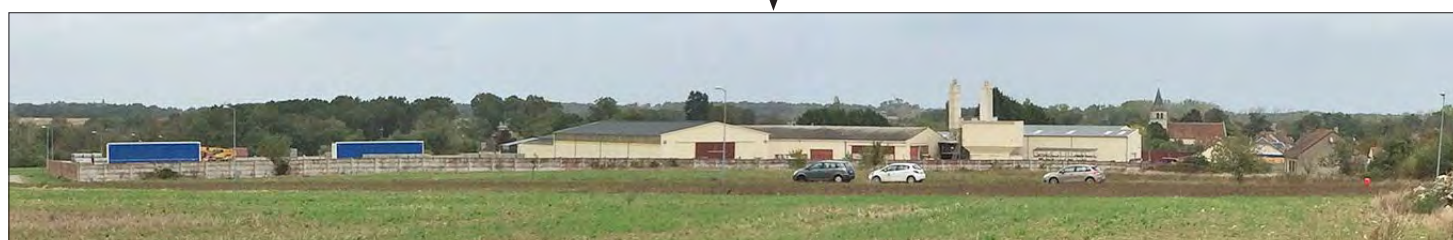
Zoom sur l'usine béton depuis le chemin du tour de ville. (octobre 2019)
