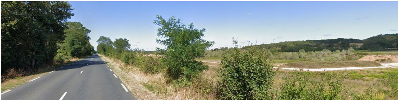
Vue 1a depuis la RD 951 sur le secteur 1 (Source : Google Maps)
