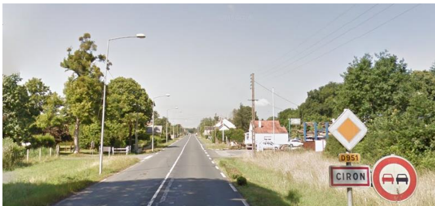
L'entrée est du village de Ciron semble suivre le même registre qu'à Scoury : logiques différentes dans l'implantation des constructions par rapport à la route, donnant une impression de grands vides là où les constructions ont été édifiées très en retrait.
