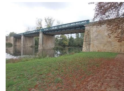
Pont métallique sur L'Anglin à Ingrandes
