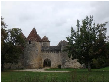
Château des Forges à Concremiers
