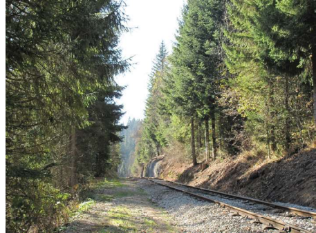
5 à 7. Voie ferrée
